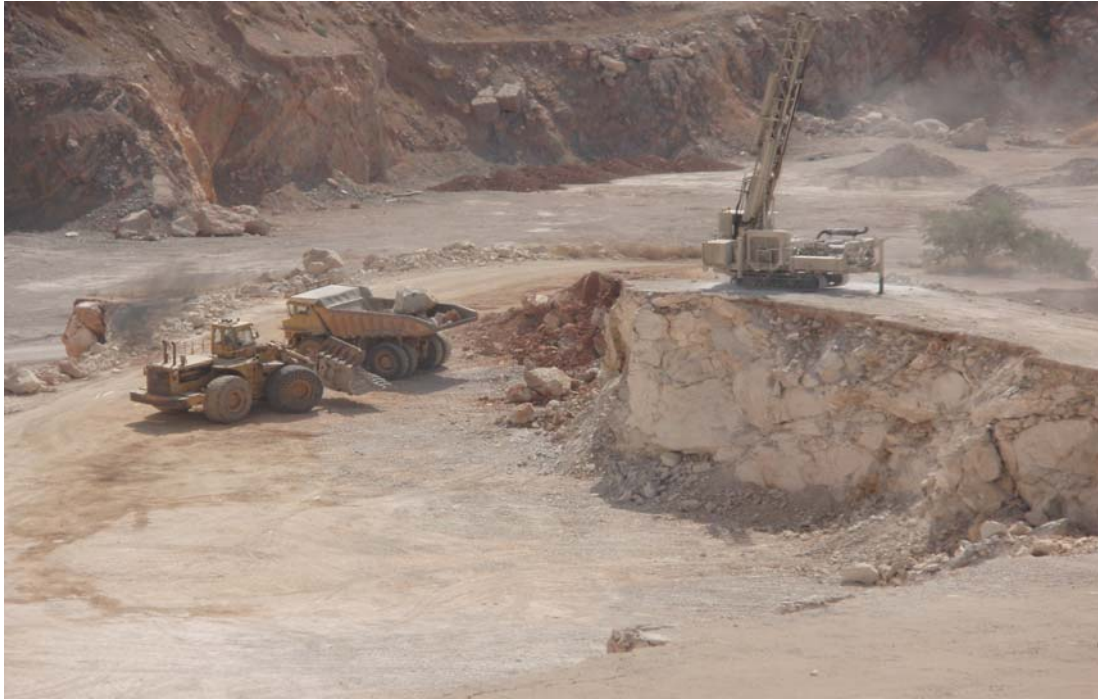
Εικόνα 1.9: Διαδικασία διάτρησης των βαθμίδων του λατομείου
