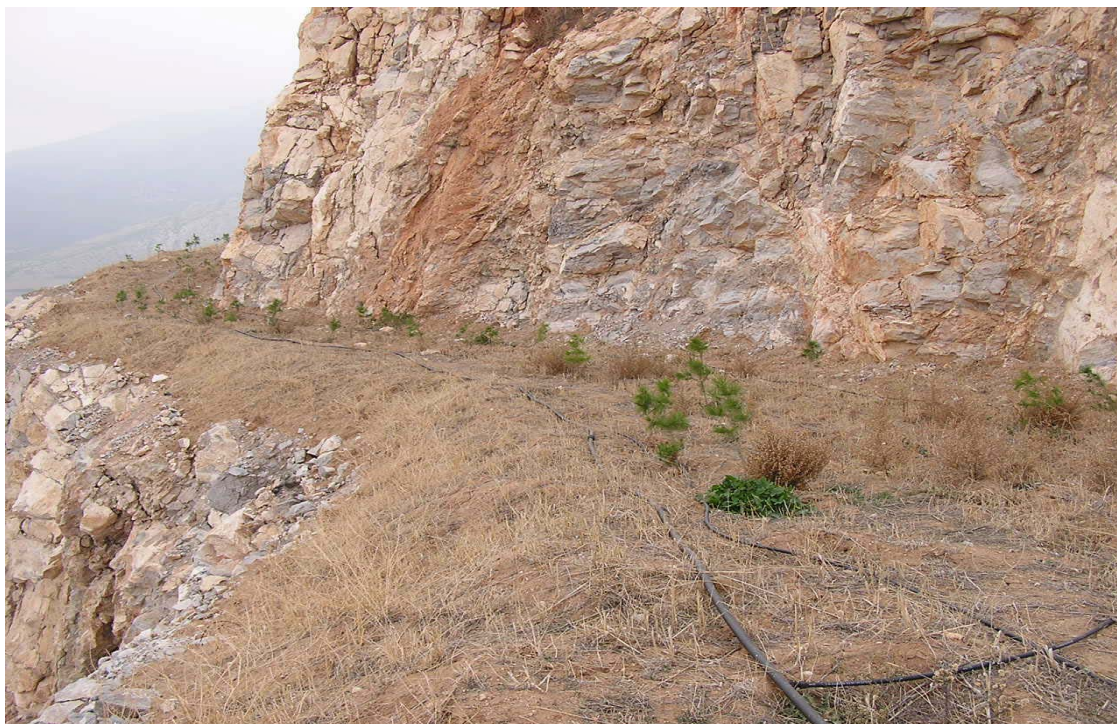
Εικόνα 4.1: Έργα αποκατάστασης στις ήδη εξοφλημένες βαθμίδες.
