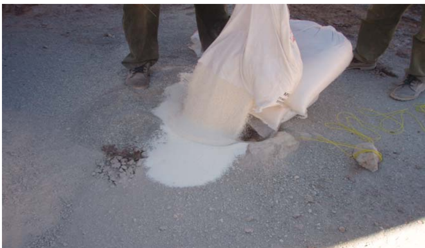
Εικόνα 1.10: Γόμωση διατρήματος.
