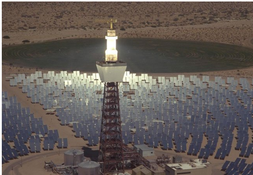
Σχήμα Γ.6.17. Δέκτης πύργου ισχύος
