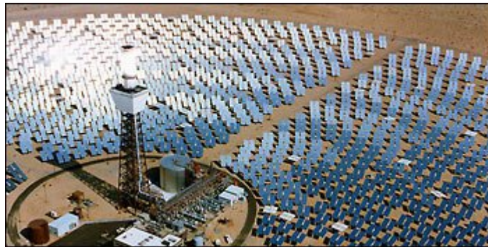
Σχήμα Γ.6.4. Ο ηλιακός πύργος Solar two
