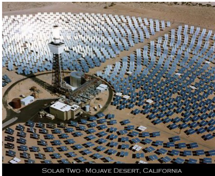
Σχήμα Γ.6.1. Σύστημα ηλιακού πύργου ισχύος στην έρημο Mojave
