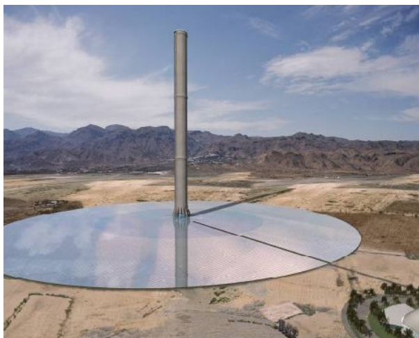
Σχήμα Γ.10.1. Εγκατάσταση ηλιακής καμινάδας
