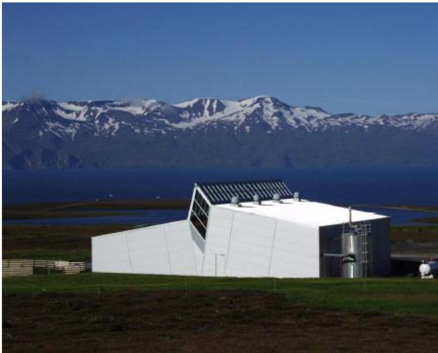
Σχήμα 55. Husavik power plant
