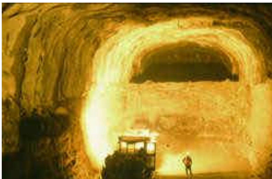
Εικόνα 3.17 Όρυξη βαθμίδας κατά την δημιουργία υπόγειου θαλάμου αποθήκευσης υδρογονανθράκων στην Αυστραλία.
