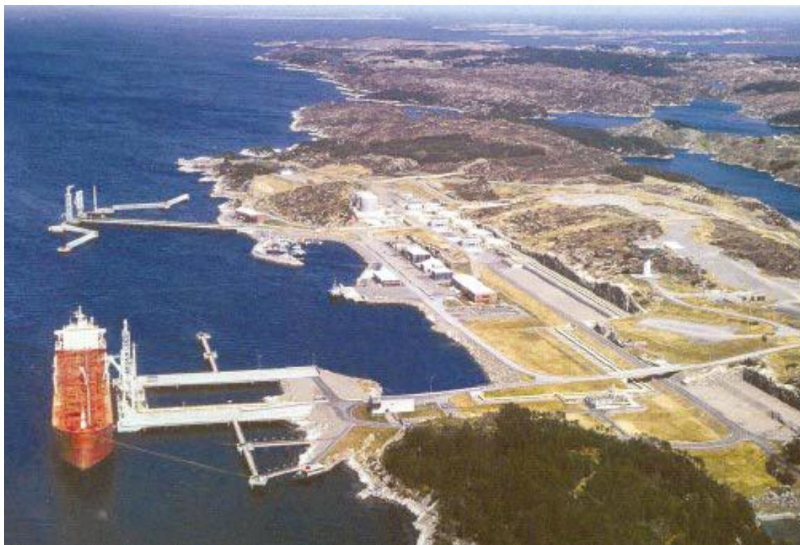
Εικόνα 3.5 Άποψη επιφανειακών εγκαταστάσεων υπόγειου συγκροτήματος αποθήκευσης (Sture, Νορβηγία)
