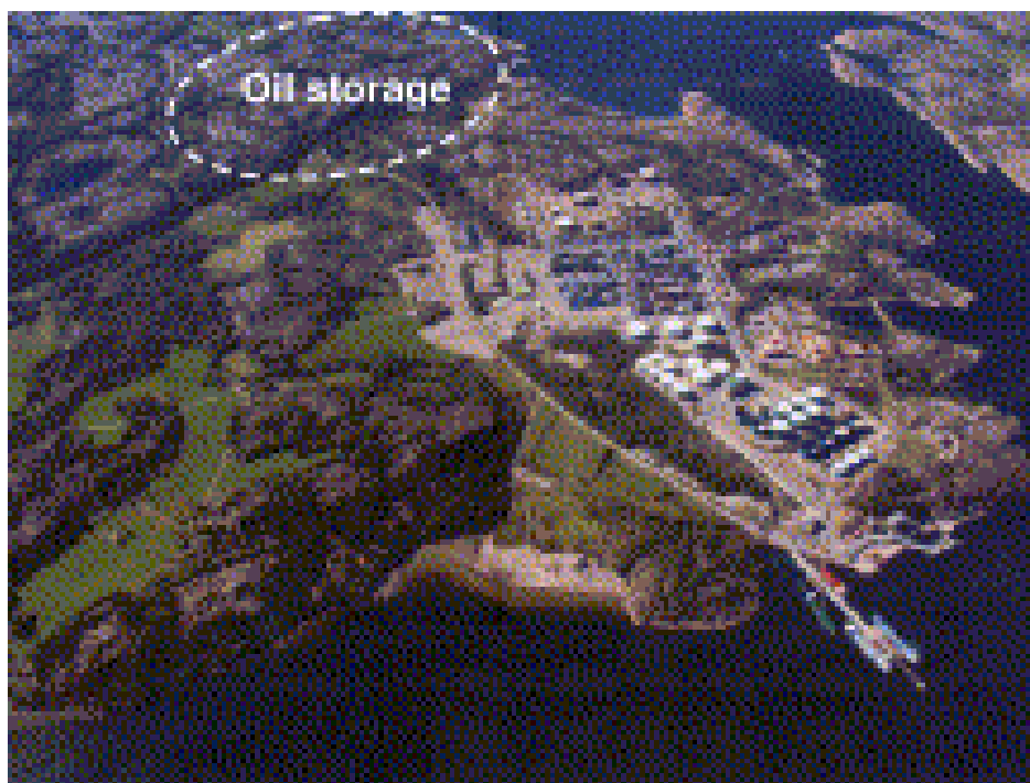
Εικόνα 3.1 Επισκόπηση του περιβάλλοντος χώρου της αποθήκευσης πετρελαίου Brofjorden.
