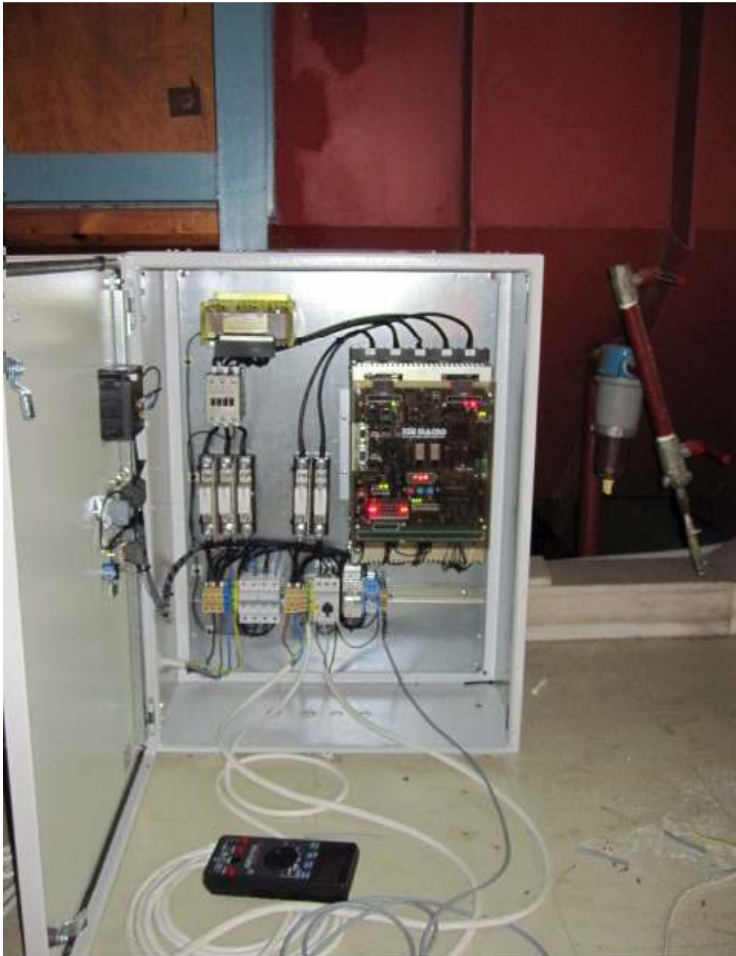
2.4.3.3 Ο πίνακας ελέγχου του κινητήρα όπου φαίνονται οι συνδέσεις από όπου παίρναμε το σήμα του ρεύματος και της τάσης του κινητήρα, της τάσης της διέγερσης καθώς και της τάσης της ταχογεννήτριας για την μέτρηση της ταχύτητας περιστροφής του δρομέα The motor control box whence we were getting the signal of the current and the voltage of the DC motor, the excitation voltage and the voltage of the tachogenerator for the measurement of the rotor rotational speed
