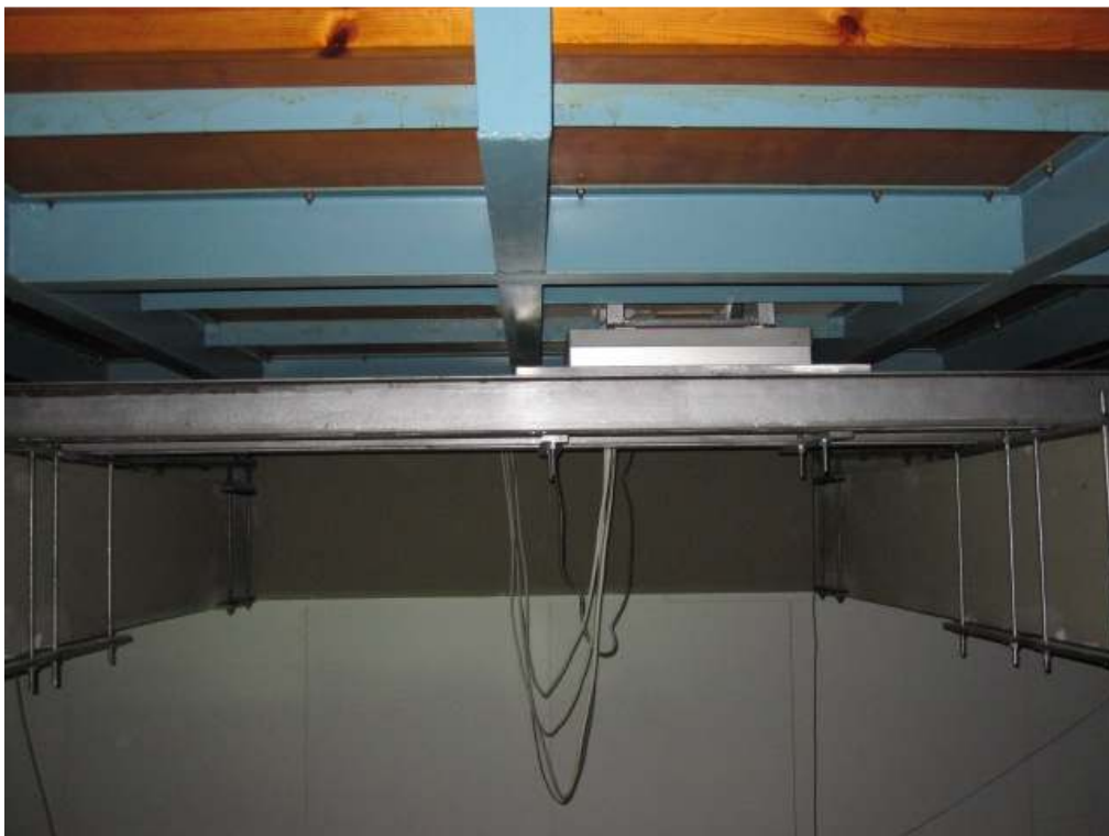
2.4.1.5 Φωτογραφία της κατασκευής όπως εκτείνεται κάτω του πατώματος του τμήματος δοκιμών, όπου φαίνονται οι ράβδοι που στηρίζουν το ικρίωμα στις τσιμεντένιες δοκούς και ο ζυγός Photo of the construction under the floor of the test section, we can see the bars supporting the tower upon the beams of cement and the load pad
