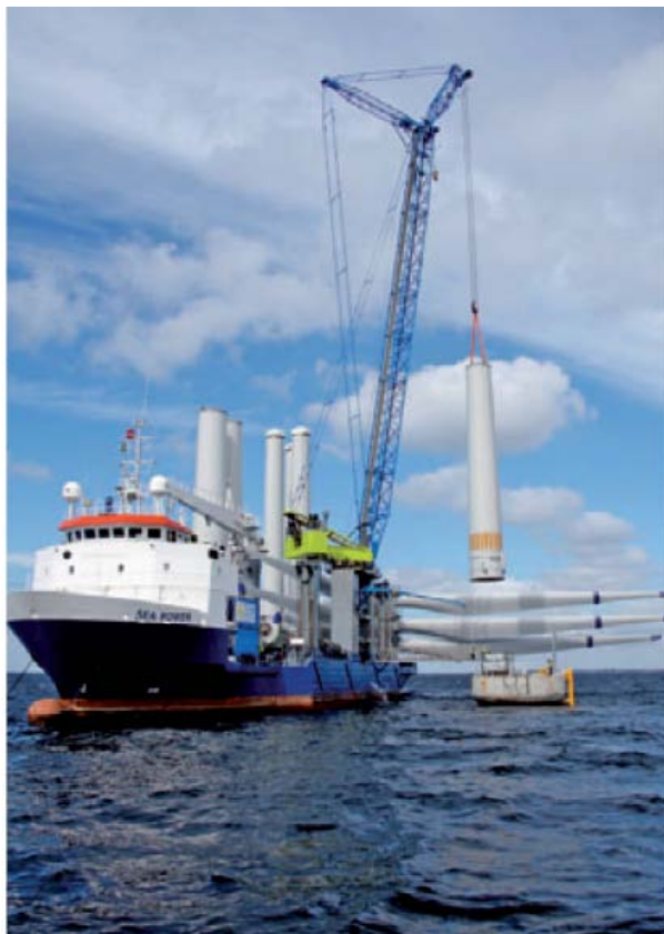
Εικόνα 4-4. Εγκατάσταση με ειδικό σκάφος – γερανοφόρο.
