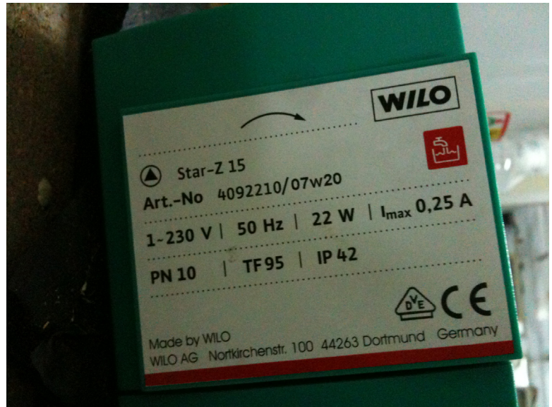
Σχήμα 42,43:Κυκλοφορητής της πειραματικής διάταξης ,Στοιχεία του κυκλοφορητή όπως φαίνονται πάνω σε αυτόν
