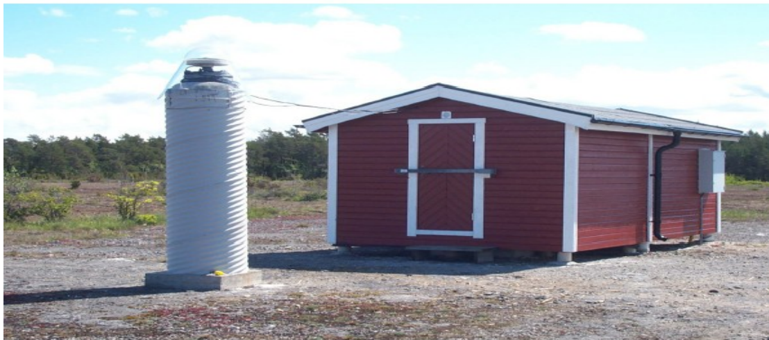
ΕΙΚΟΝΑ 2.2 ΤΥΠΙΚΗ ΔΙΑΤΑΞΗ ΣΤΑΘΜΟΥ ΤΟΥ SWEPOS (ΠΗΓΗ: http://www.lantmateriet.se/ )
