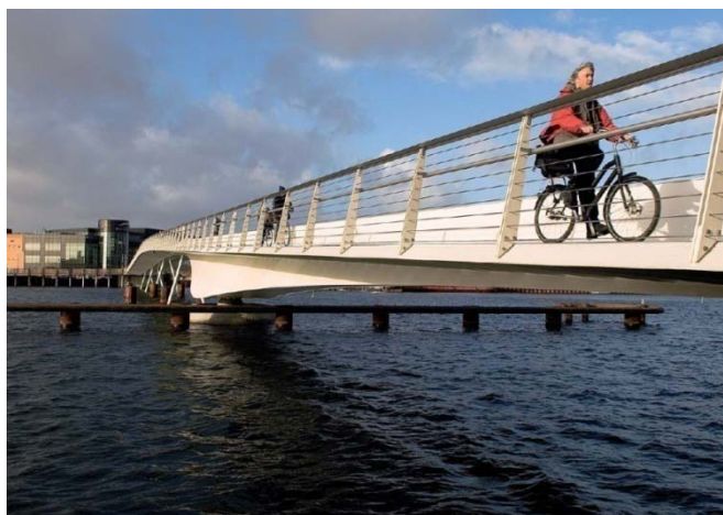
Εικόνα 26, Η γέφυρα Bryggebroen, Κοπεγχάγη
