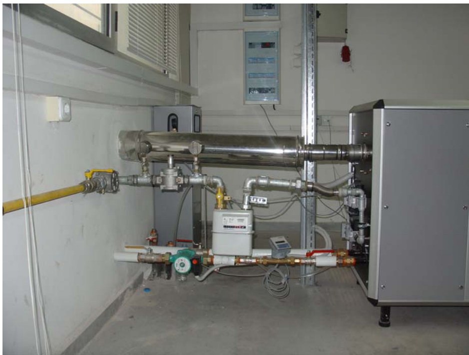
Σχήμα 6.4: Γραμμή τροφοδοσίας φυσικού αερίου μετά την ολοκλήρωση των εργασιών. (Σχολή Μηχανολόγων Μηχανικών Ε.Μ.Π. – Εργαστήριο Εφαρμοσμένης Θερμοδυναμικής)
