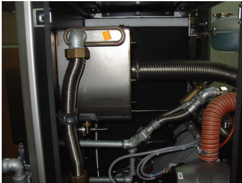
Σχήμα 5.14: Εναλλάκτης καυσαερίων.
