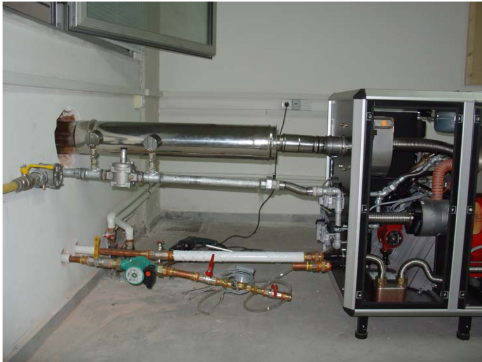
Σχήμα 6.3: Εργασίες για τη σύνδεση γραμμής τροφοδοσίας φυσικού αερίου. (Σχολή Μηχανολόγων Μηχανικών Ε.Μ.Π. – Εργαστήριο Εφαρμοσμένης Θερμοδυναμικής)
