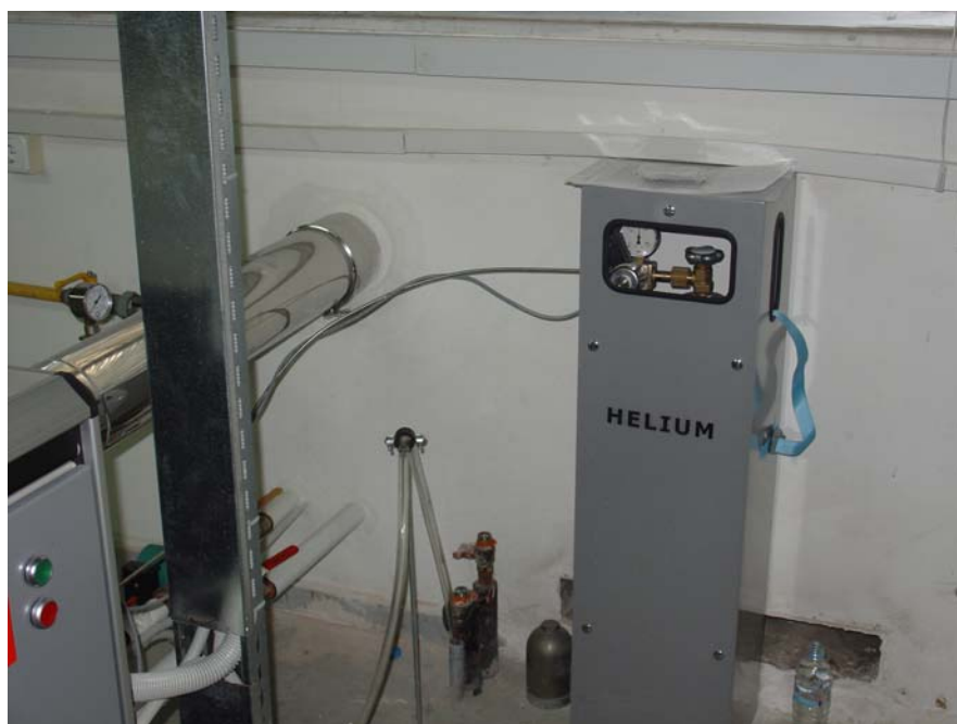
Σχήμα 6.10: Εσωτερικό μέρος καπναγωγού, σιφόνι συμπυκνωμάτων και εξωτερική φιάλη αποθήκευσης He (Σχολή Μηχανολόγων Μηχανικών Ε.Μ.Π. – Εργαστήριο Εφαρμοσμένης Θερμοδυναμικής)
