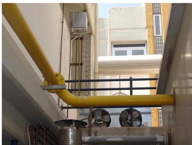
Σχήμα 6.7: Ψύκτης αέρα και ανοικτό δοχείο διαστολής (Σχολή Μηχανολόγων Μηχανικών Ε.Μ.Π. – Εργαστήριο Εφαρμοσμένης Θερμοδυναμικής)
