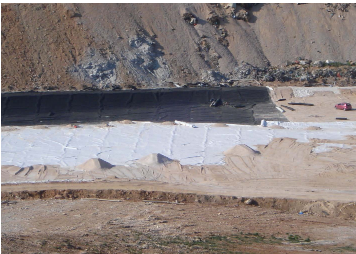
Φωτογραφία 6 :Στεγανοποίηση πυθμένα κυττάρου Χ.Υ.Τ.Α
