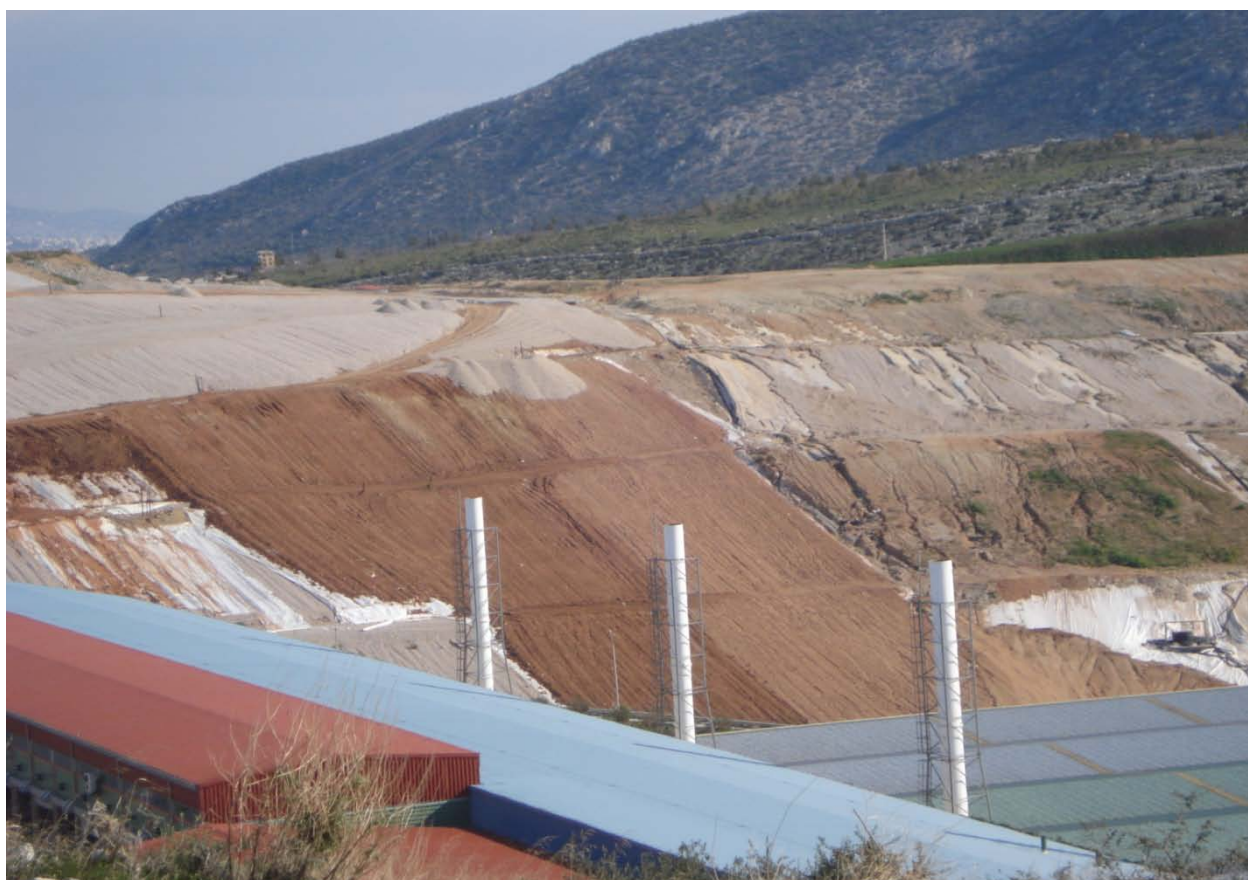
Φωτογραφία 4 : Κύτταρο Χ.Υ.Τ.Α υπό αποκατάσταση, κτίριο της ΕΜΑΚ
