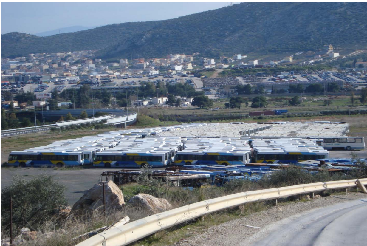
Φωτογραφία 17 : Αμαξοστάσιο της Ε.Θ.Ε.Λ. νότια του δήμου
