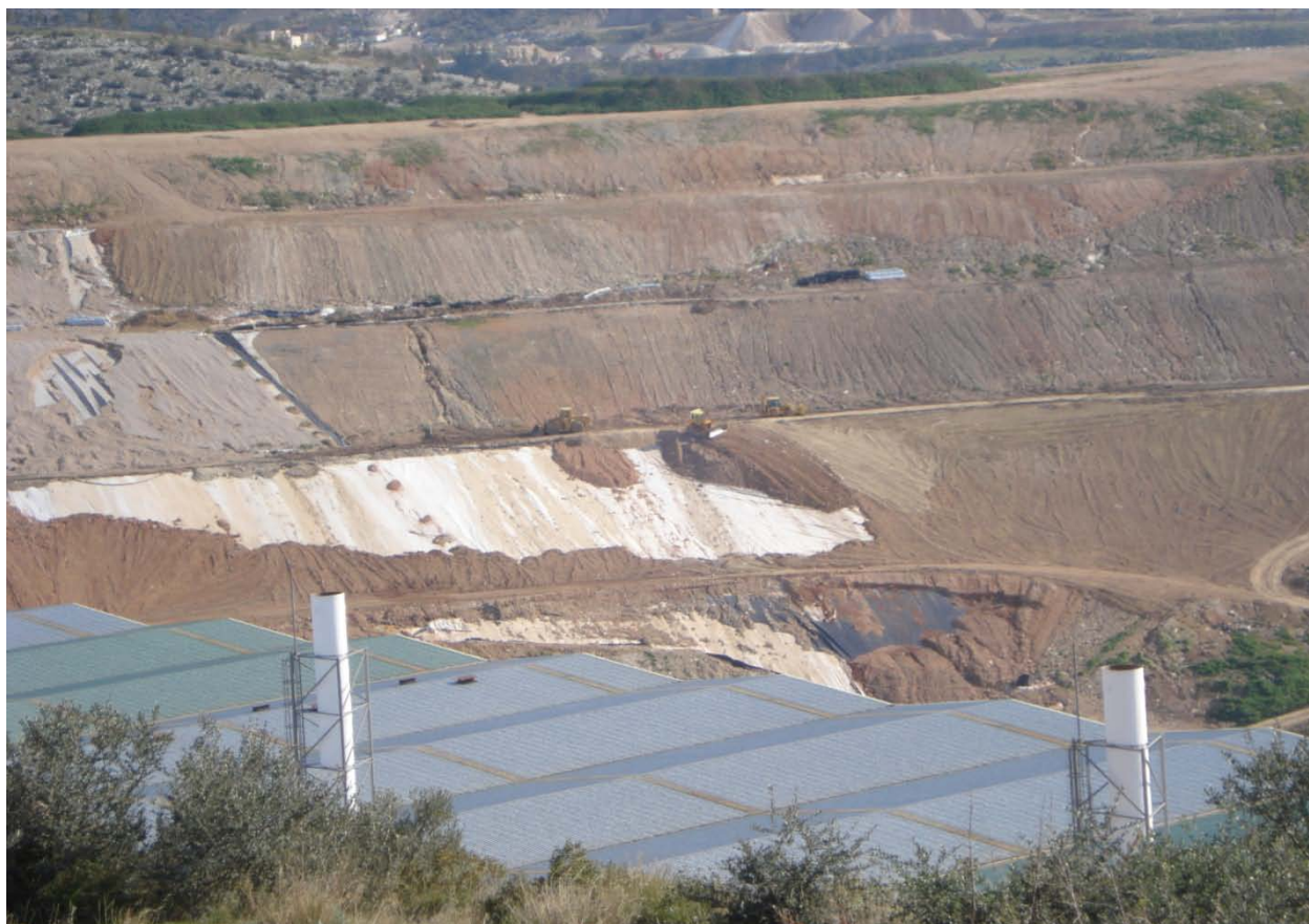
Φωτογραφία 3 : Κύτταρο Χ.Υ.Τ.Α υπό αποκατάσταση, κτίριο της ΕΜΑΚ
