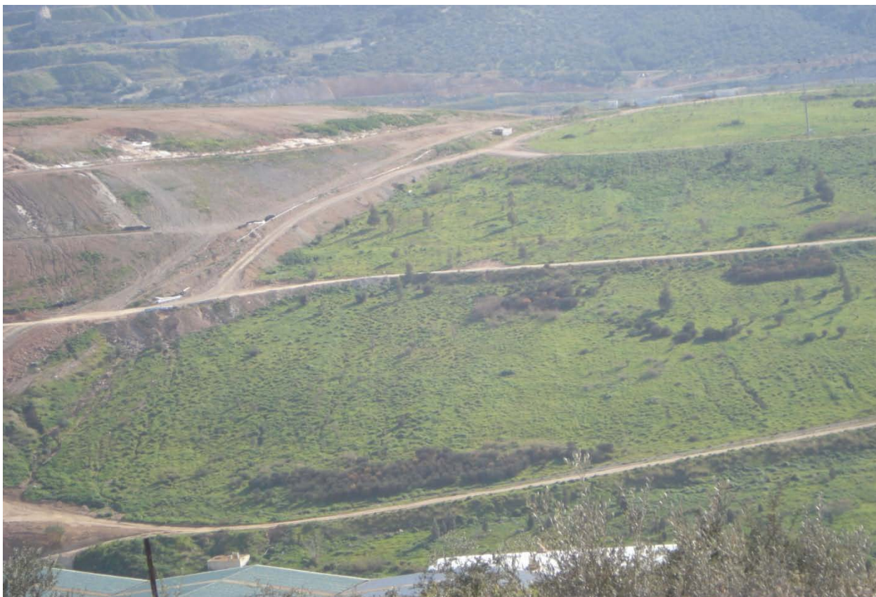
Φωτογραφία 1 : Αποκατεστημένος Χ.Δ.Α. και κύτταρο Χ.Υ.Τ.Α υπό αποκατάσταση
