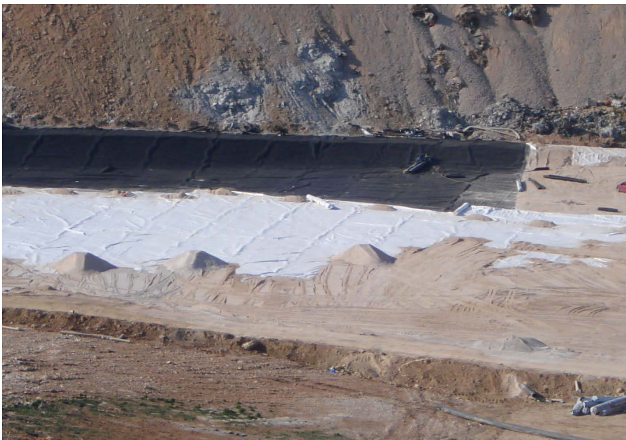
Φωτογραφία 5 : Στεγανοποίηση πυθμένα κυττάρου Χ.Υ.Τ.Α
