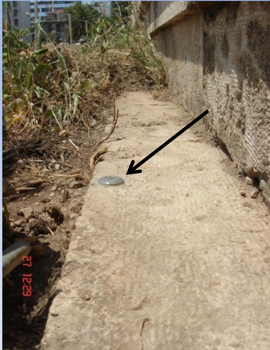
Ορειχάλκινο μπουλόνι εγκατεστημένο στην ευθυντηρία
