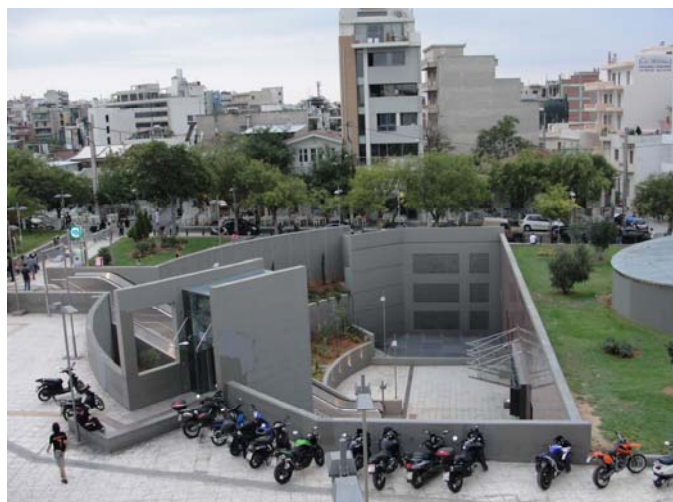
Εικόνα 26: Ανάπλαση σταθμού Μετρό στην κεντρική πλατεία του Γκαζοχωρίου Πηγή: Ιδία επεξεργασία
