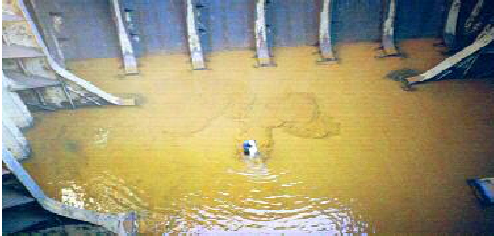
Εικ 21. Εναπόθεση ιζημάτων στο χώρο φορτίου που έχει χρησιμοποιηθεί σαν δεξαμενή έρματος.
