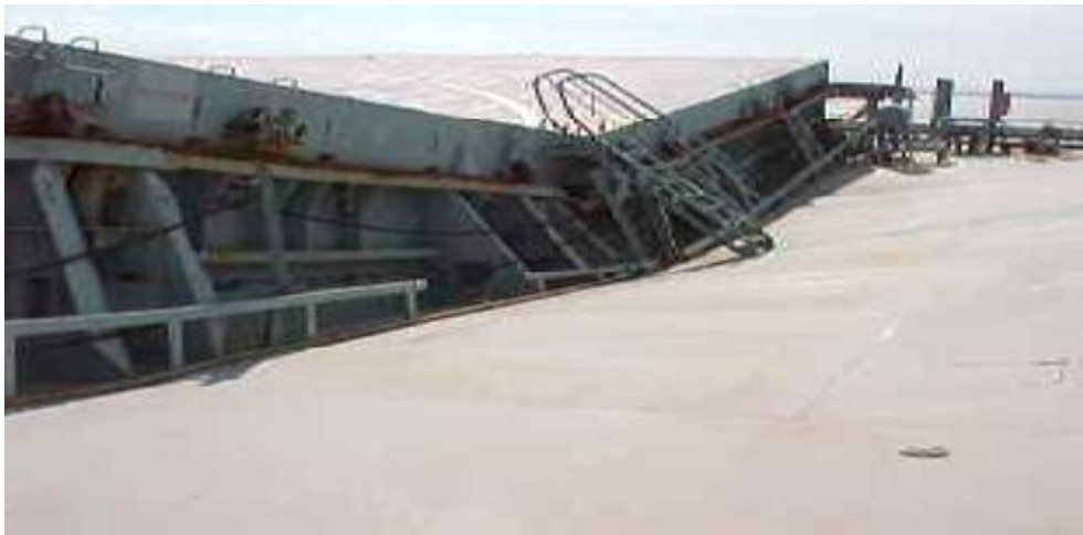
Εικ. 17. Καταστροφή δεξαμενής λόγω υπερπίεσης.
