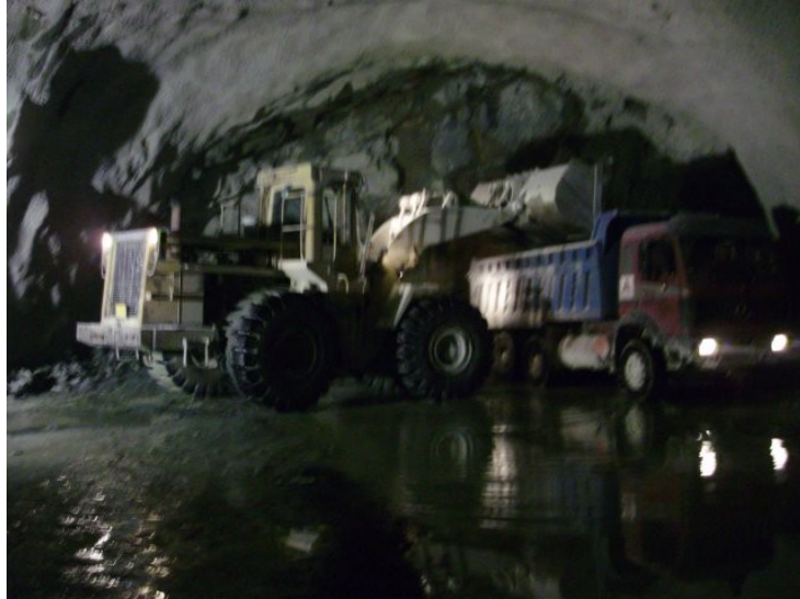
Σχήμα 5.9: Αποκομιδή των υλικών της ανατίναξης από το μέτωπο της σήραγγας
