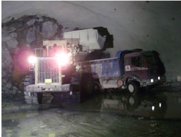
Σχήμα 1.5: Απομάκρυνση των αδρανών υλικών
