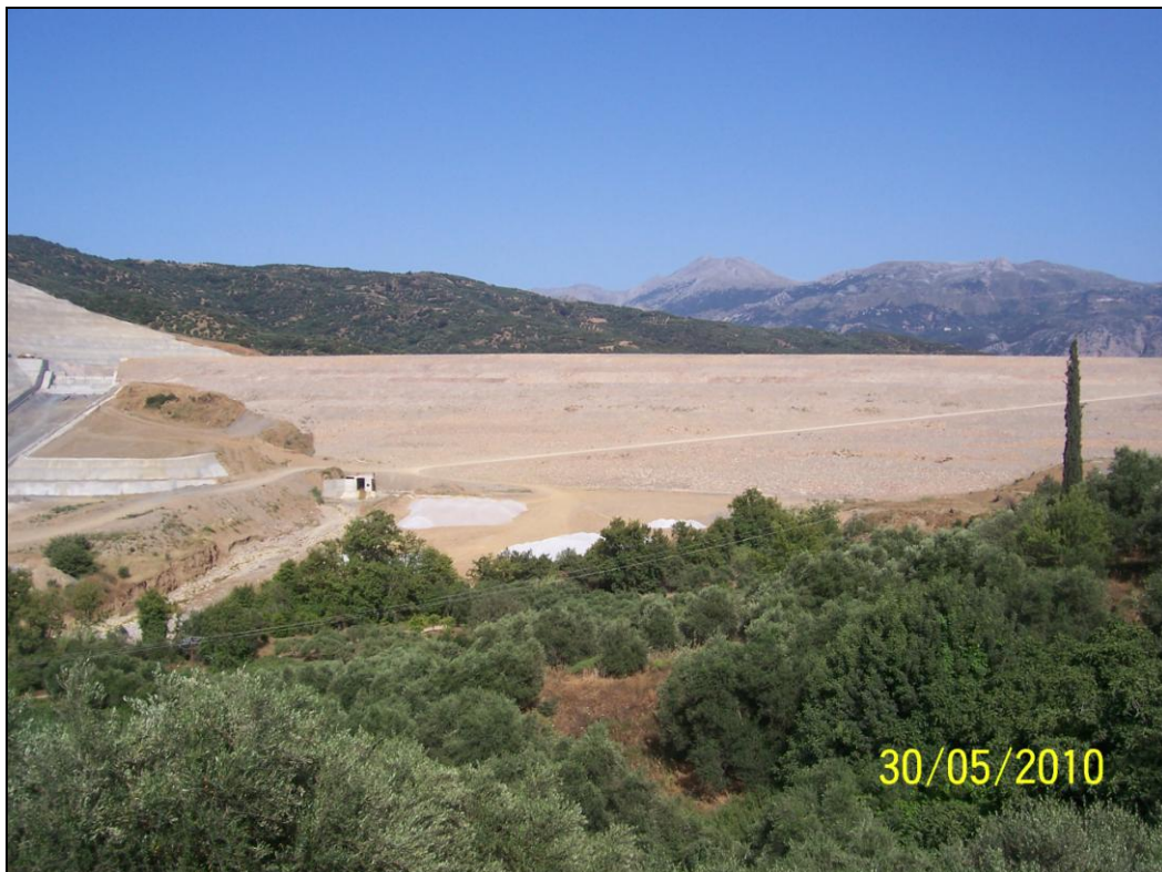
Φωτογραφία 10 : Πανοραμική όψη εργασιών του Φράγματος από Ποταμιές
