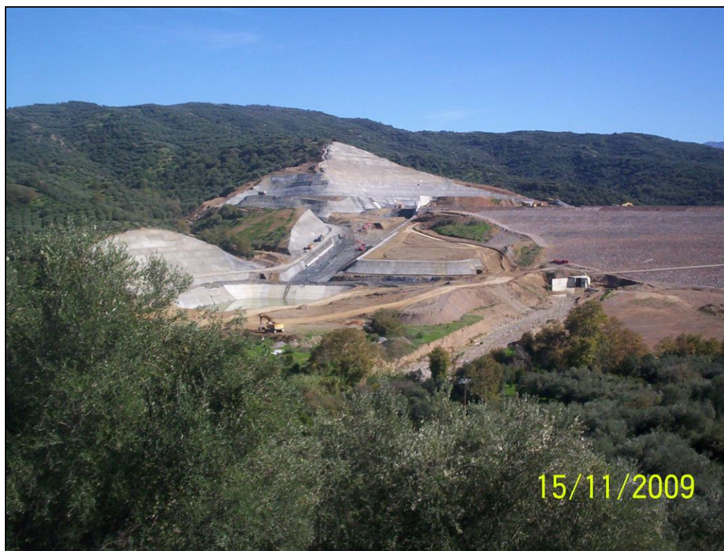
Φωτογραφία 3 : Όψη της λεκάνης καταστροφής ενέργειας του Φράγματος
