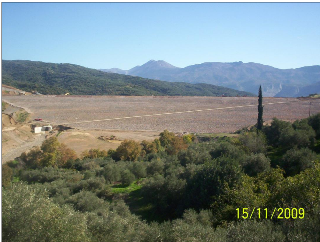
Φωτογραφία 2 : Όψη του Φράγματος και Αγωγού εκτροπής
