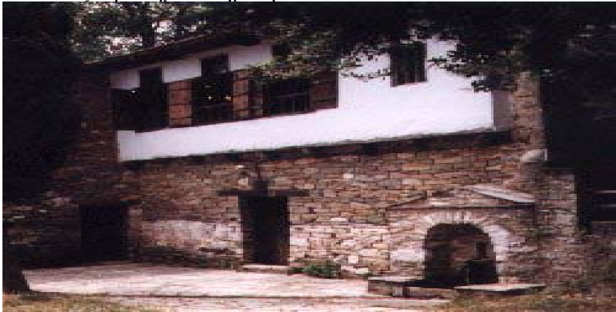
Εικόνα 4: Εξωτερικό Σχολείου Ρήγα Φεραίου.
