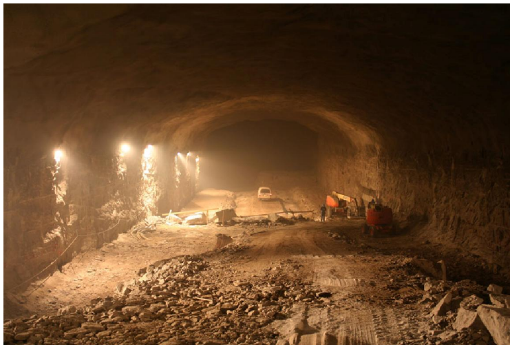
Εικόνα 1.26: Άποψη εργασιών κατά την φάση διάνοιξης του κέντρου επεξεργασίας λυμάτων Viikinmaki
