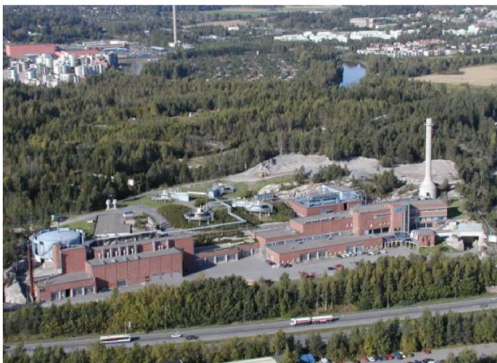
Εικόνα 1.15: Επιφανειακή άποψη του Κέντρου Επεξεργασίας Λυμάτων Viihinmaki, Φινλανδία
