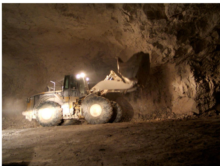
Εικόνα 1.37: Κατασκευή των θαλάμων του κέντρου επεξεργασίας λυμάτων Kakolanmaki
