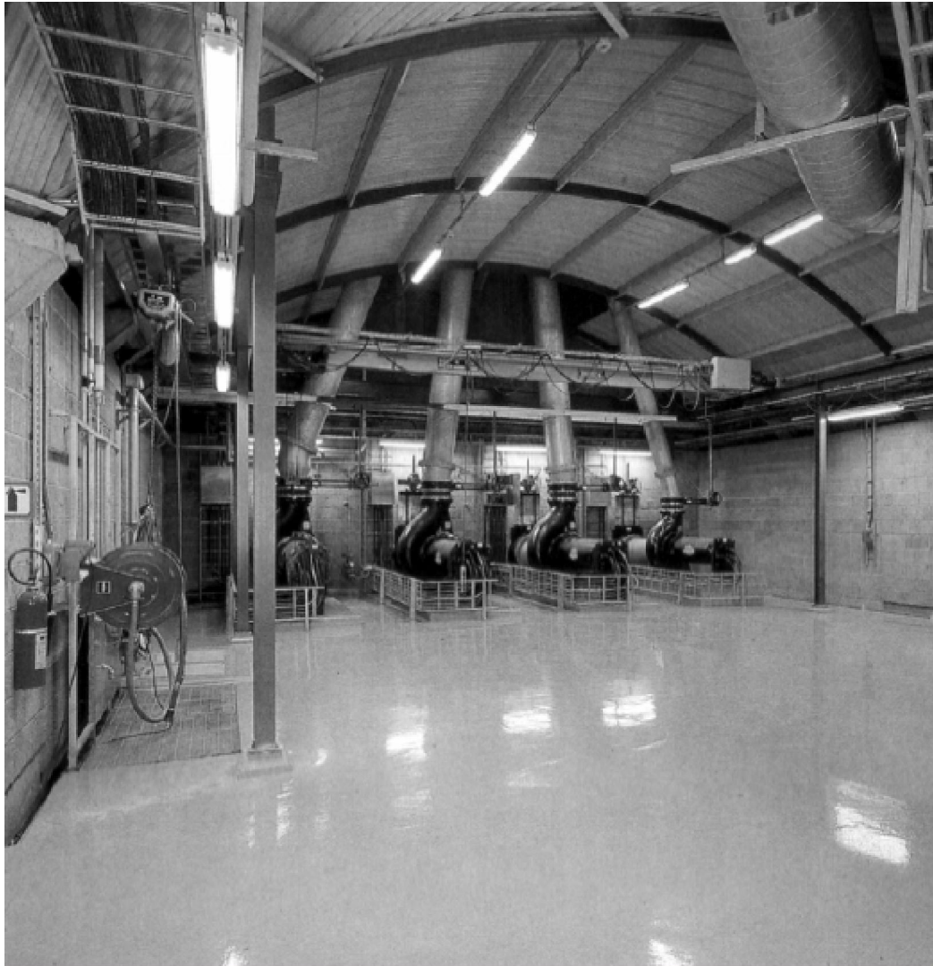
Εικόνα 1.46: Άντληση των λυμάτων για την περαιτέρω επεξεργασία τους
