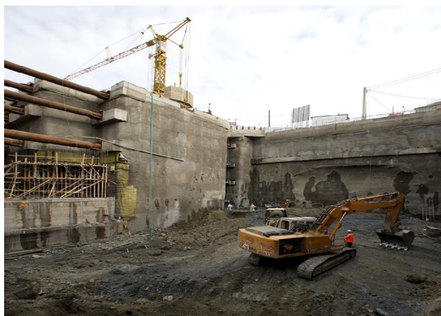
Εικόνα 4.5: Στάδιο κατασκευής σταθμού μετρό στην Αθήνα με την μέθοδο Cut & Cover
