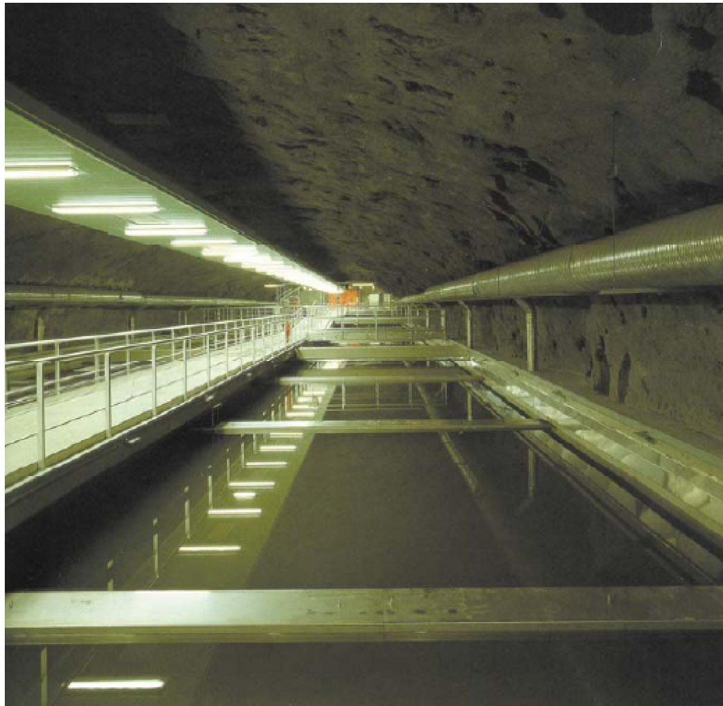
Εικόνα 1.45: Υπόγεια δεξαμενή του κέντρου επεξεργασίας λυμάτων Stavanger
