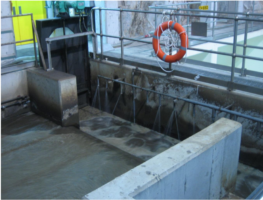
Εικόνα 1.58: Υπόγειος θάλαμος κέντρου επεξεργασίας λυμάτων Stanley
