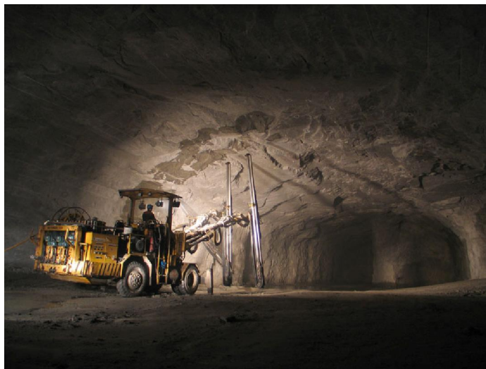
Εικόνα 1.24: Άποψη εργασιών κατά την φάση διάνοιξης και υποστήριξης του κέντρου επεξεργασίας λυμάτων Viikinmaki
