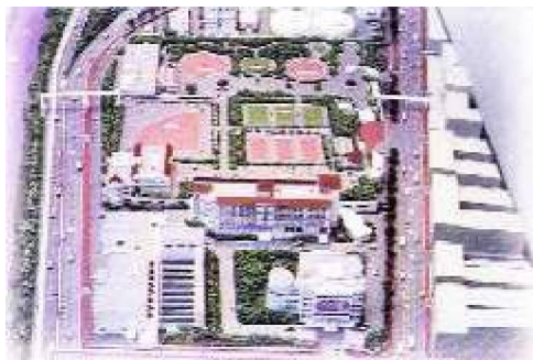
Εικόνα 1.69: Επιφανειακή άποψη της αποκατάστασης του υπόγειου κέντρου επεξεργασίας λυμάτων Dìhua
