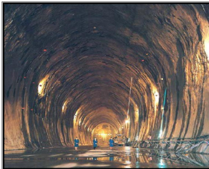
Εικόνα 1.4: Θάλαμος αποθήκευσης αργού πετρελαίου στην Ιαπωνία
