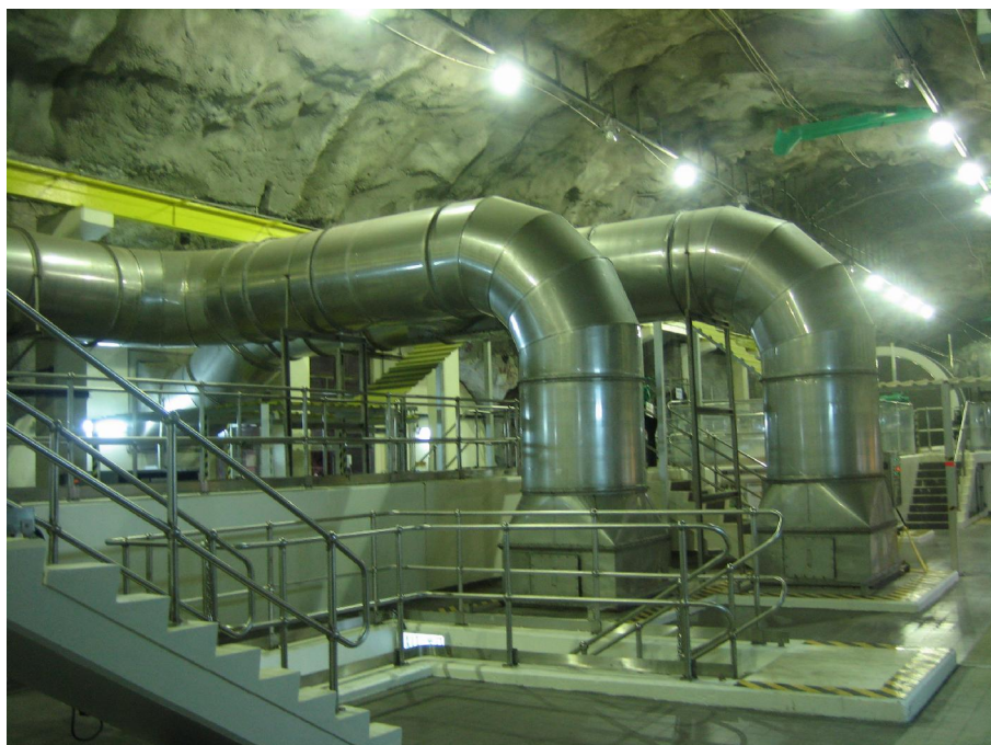
Εικόνα 1.53: Υπόγειος θάλαμος κέντρου επεξεργασίας λυμάτων Stanley
