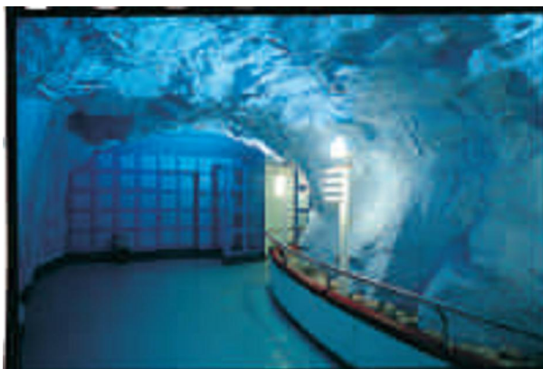
Εικόνα 1.62: Στοά του κέντρου επεξεργασίας λυμάτων Henriksdal
