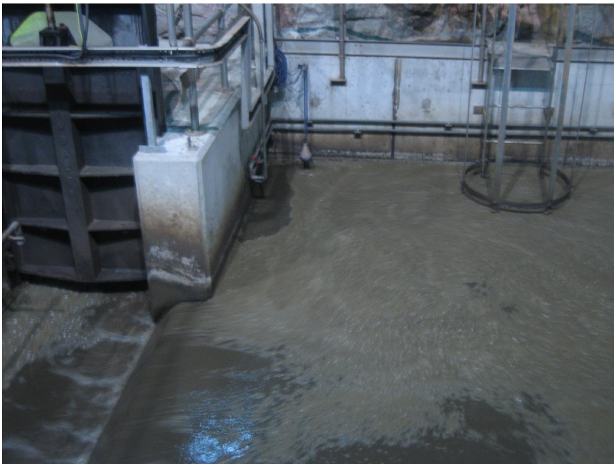
Εικόνα 1.59: Υπόγειος θάλαμος κέντρου επεξεργασίας λυμάτων Stanley
