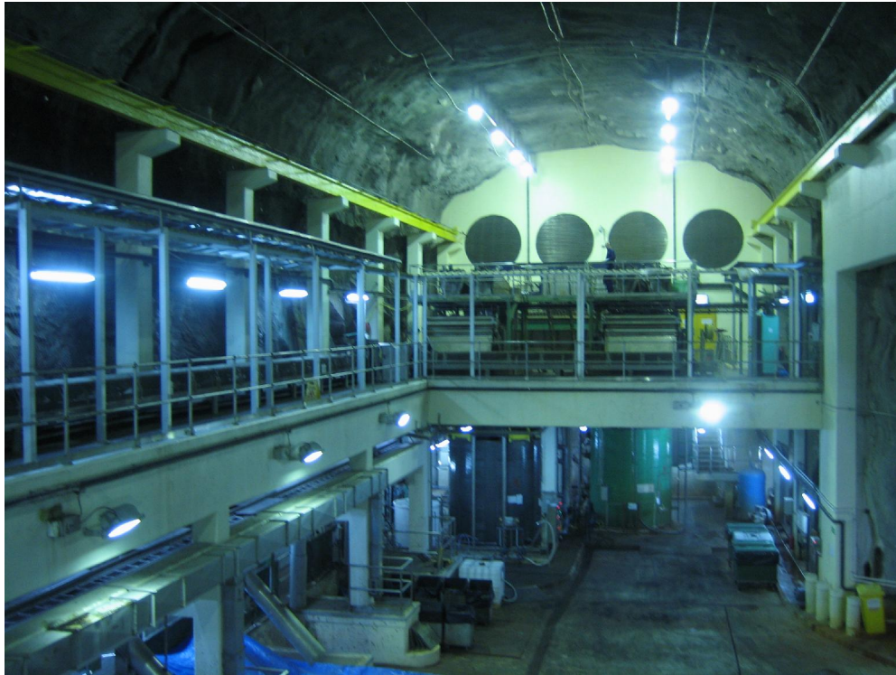
Εικόνα 1.56: Υπόγειος θάλαμος κέντρου επεξεργασίας λυμάτων Stanley
