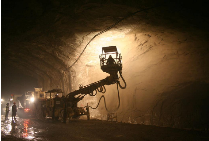
Εικόνα 1.25: Άποψη εργασιών κατά την φάση διάνοιξης του κέντρου επεξεργασίας λυμάτων Viikinmaki
