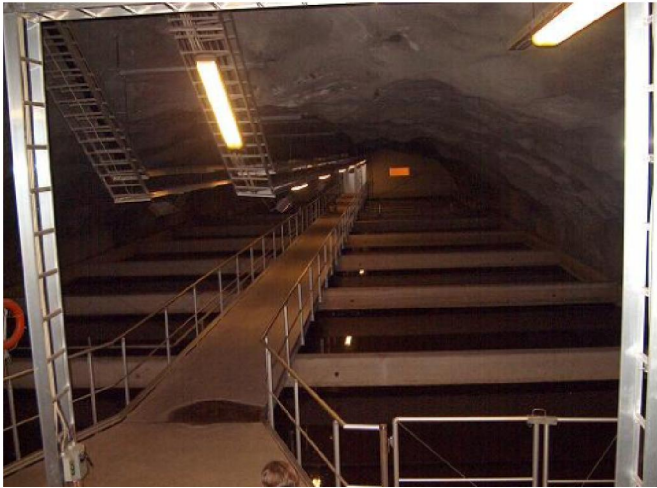
Εικόνα 1.19: Υπόγειες δεξαμενές του κέντρου επεξεργασίας λυμάτων Viikinmaki
