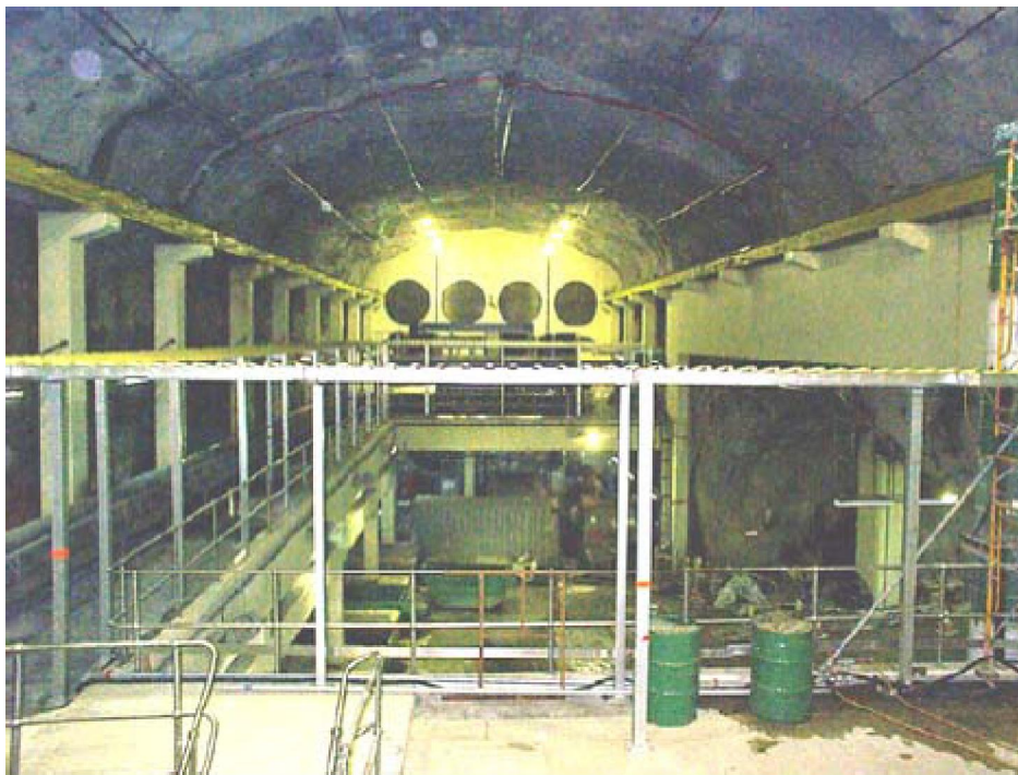
Εικόνα 1.48: Εσωτερικό υπόγειου θαλάμου Stanley
