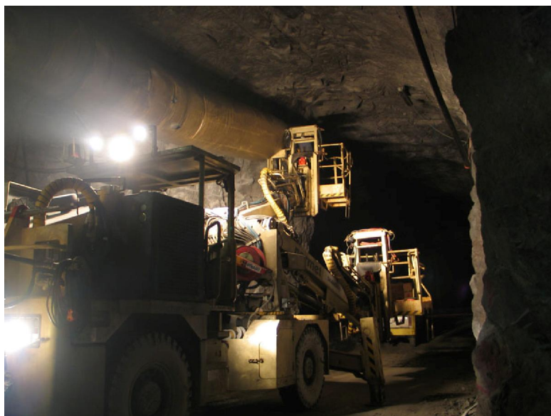
Εικόνα 1.22: Υπόγειος χώρος του κέντρου επεξεργασίας λυμάτων Vikiinmaki κατά την φάση κατασκευής
