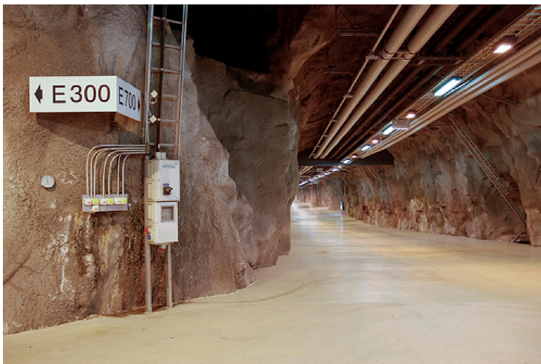
Εικόνα 1.11: Υπόγειος χώρος κέντρου επεξεργασίας λυμάτων Viikinmaki, Φιλανδία
