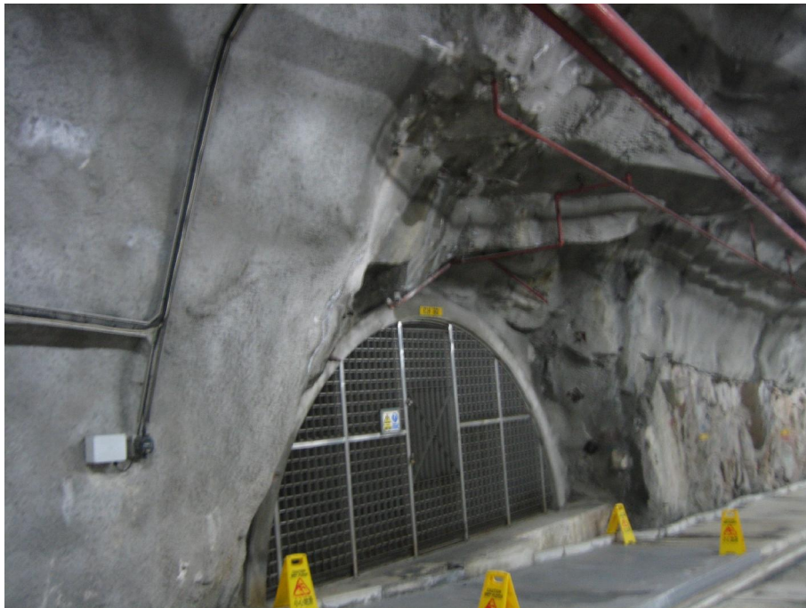
Εικόνα 1.57: Σήραγγα υπόγειου κέντρου επεξεργασίας λυμάτων Stanley
