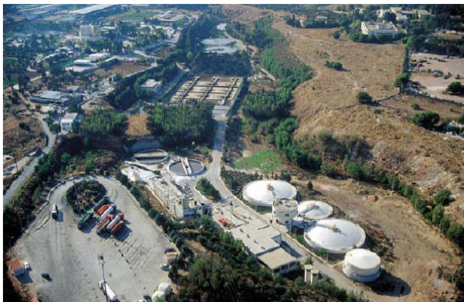
Εικόνα 2.3: Άποψη εγκαταστάσεων ΚΕΛ Μεταμόρφωσης
