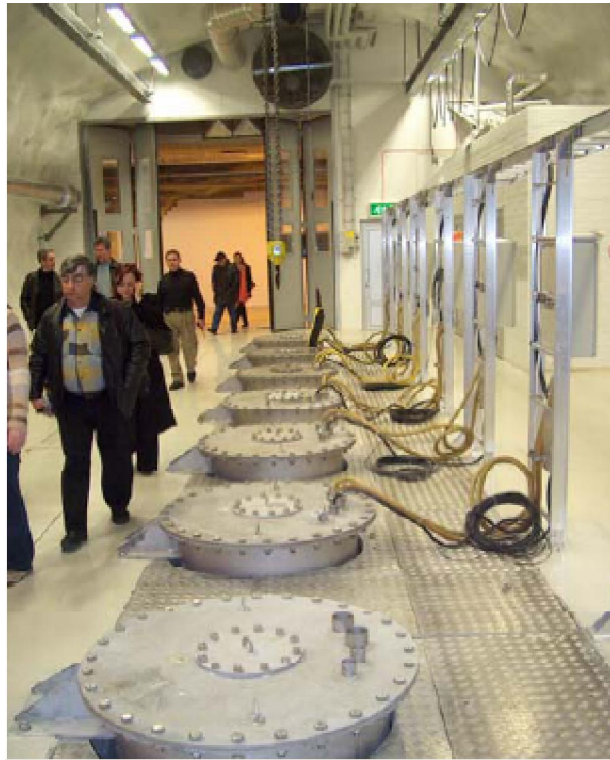
Εικόνα 1.29: Υπόγειοι χώροι του κέντρου επεξεργασίας λιμάτων
