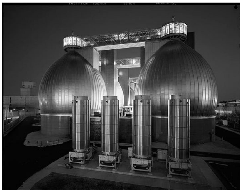
Εικόνα 1.66: Συγκρότημα βιολογικού καθαρισμού στην Ιταλία
