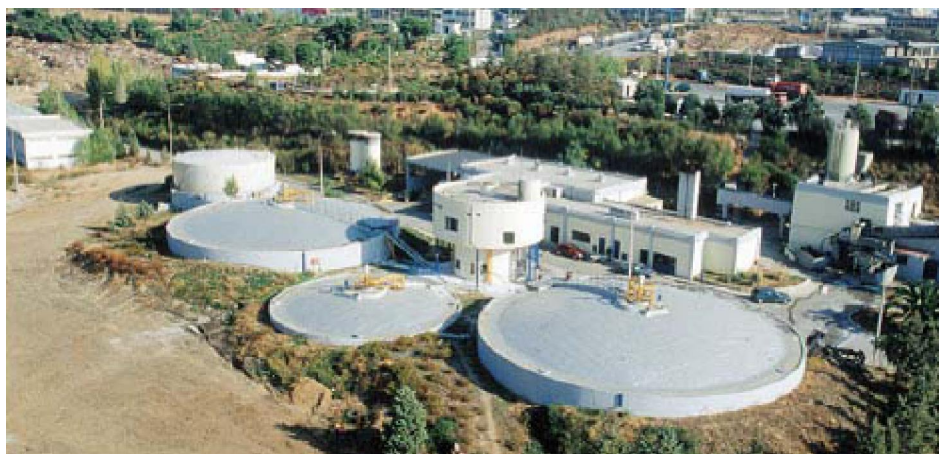
Εικόνα 2.7: Δεξαμενές χώνευσης, στο μέσο διακρίνεται το κτίριο εξυπηρέτησης των χωνευτών
