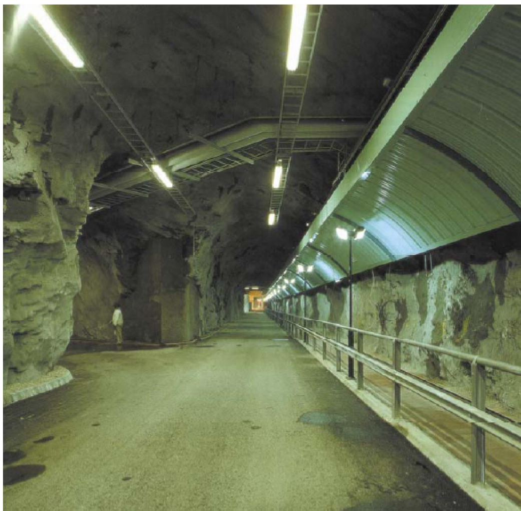
Εικόνα 1.47: Υπόγειοι θάλαμοι του κέντρου επεξεργασίας λυμάτων Stavanger
