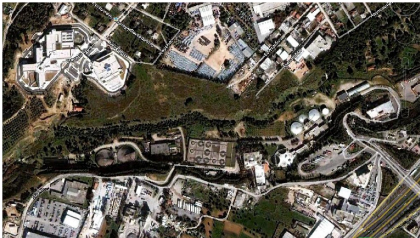
Εικόνα 3.2: Άποψη του ΚΕΛΜ από το Google earth
