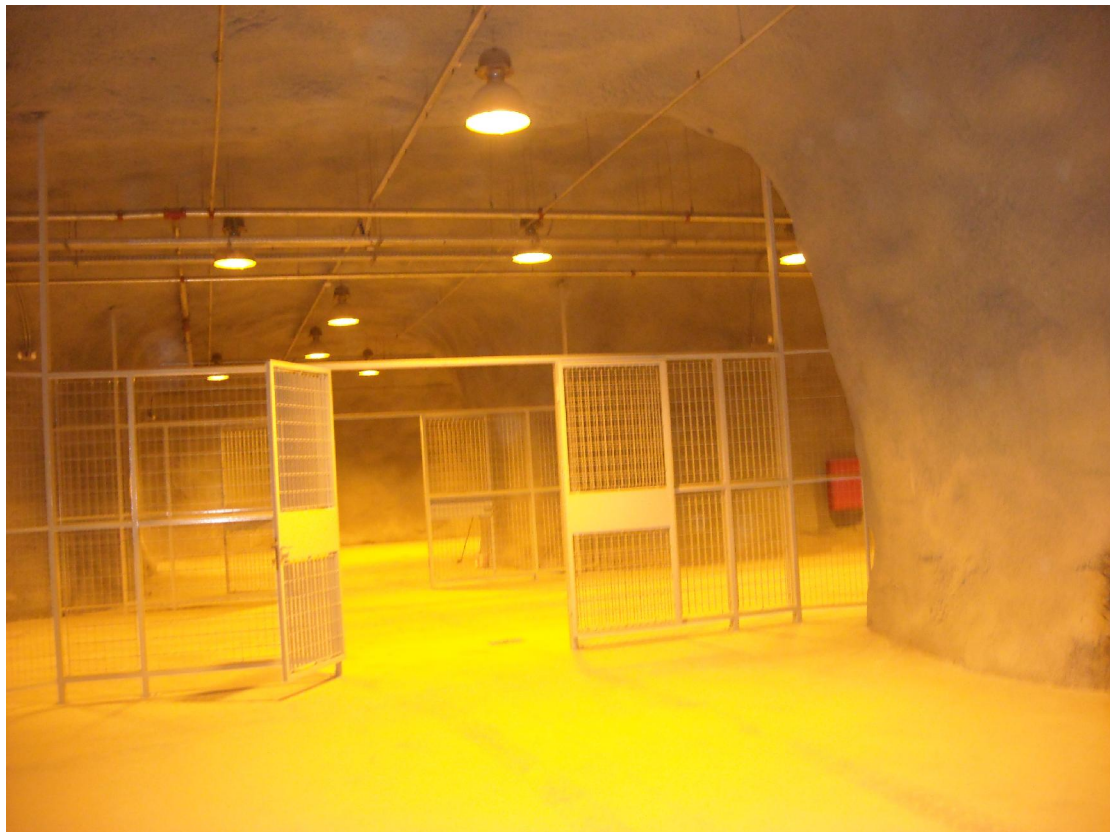
Εικόνα 1.6: Υπόγειος χώρος αποθήκευσης, Λαύριο
