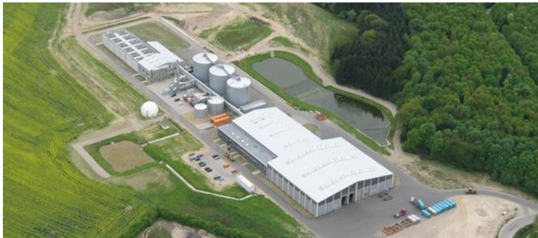
Εικόνα 6.6: Εγκαταστάσεις Μηχανικής-Βιολογικής Επεξεργασίας στο Neumuenster της Γερμανίας (Πηγή : http://www.belfastcity.gov.uk/wastetreatment/whatisMBT.asp )
