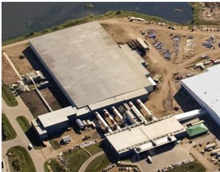
Εικόνα 6.3 : Εγκαταστάσεις κομποστοποίησης των αποβλήτων στο Edmonton του Καναδά
