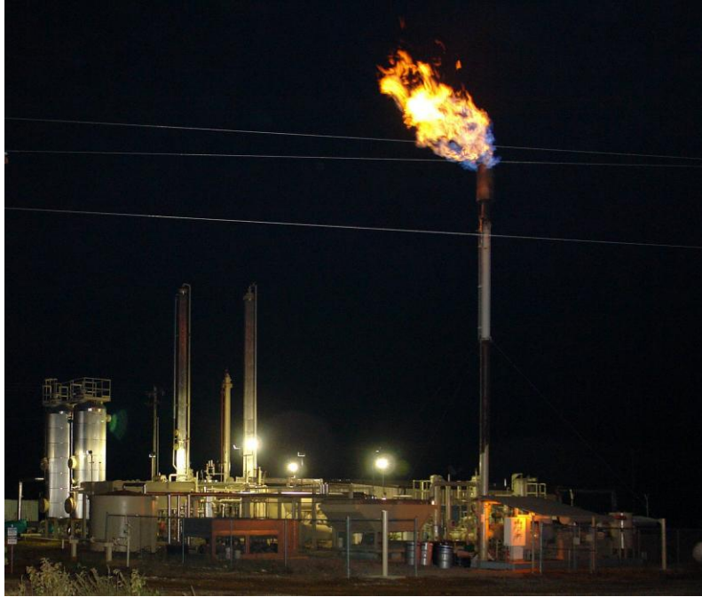
Εικόνα 6.5 : Εγκαταστάσεις ΧΥΤΑ με καύση του μεθανίου στο Fort Smith του Arkansas (Πηγή : http://www.thecitywire.com/?q=node/2065 )
