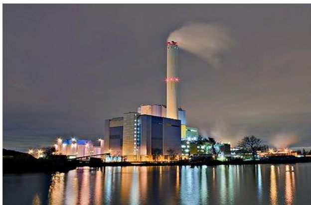
Εικόνα 6.4 :Εγκαταστάσεις αποτέφρωσης των αποβλήτων στο Oberhausen της Γερμανίας (Πηγή : http://www.oberhausen.de/en/index.php )
