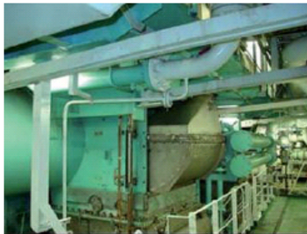
Εικ.4.19 Η εγκατάσταση στο M/V Mignon.
