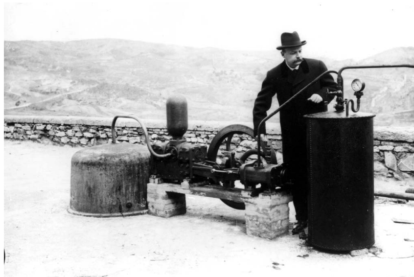
Σχήμα 4.3: Ο πρίγκιπας Piero Ginori Conti και η πειραματική διάταξη που χρησιμοποίησε το 1904 για παραγωγή ηλεκτρικής ενέργειας μέσω της γεωθερμίας [8]
