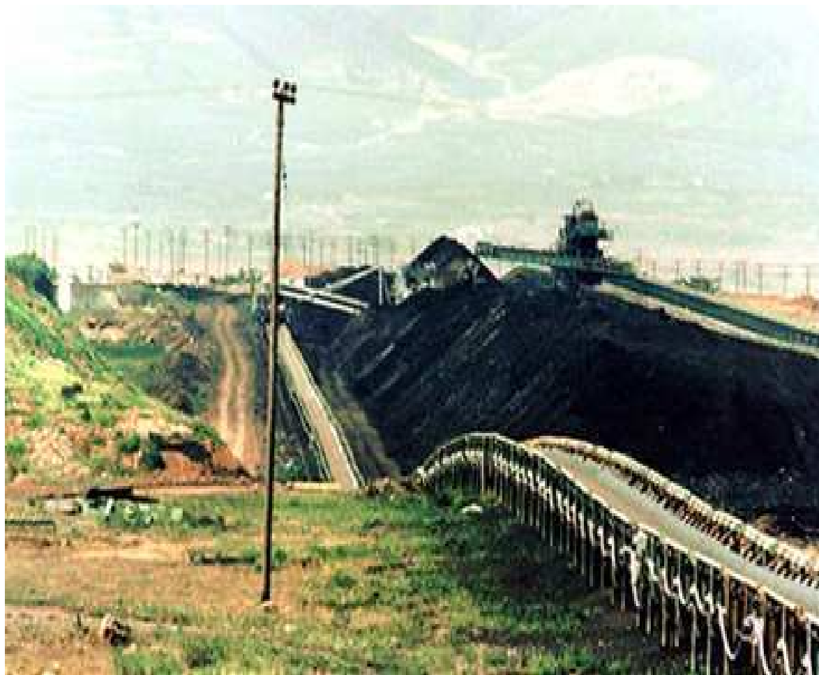
Εικόνα 5.3.3: Τμήμα των ταινιόδρομων
