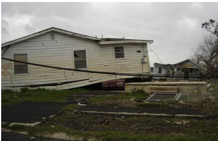
Εικόνα 2-6. Πλημμυρόπληκτη κατοικία της Νέας Ορλεάνης που παρασύρθηκε μερικά μέτρα μακριά από τη θεμελίωσή της [Πηγή: λήψη φωτογραφίας Ιανουάριος 2006 από M. Kok]
