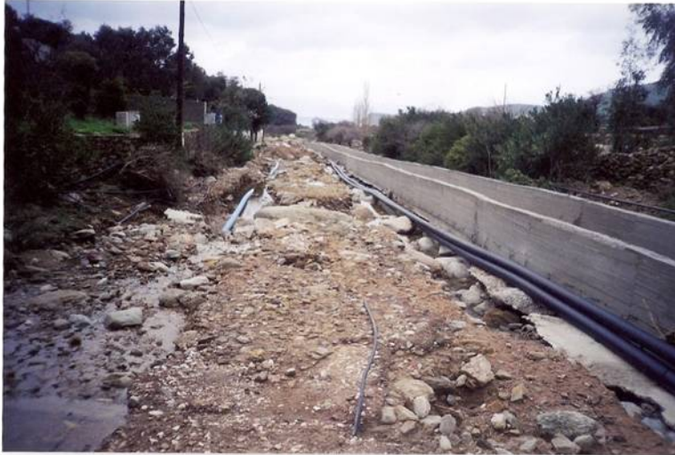
Εικόνα 13-4. Οδοποιία προσπέλασης στο φράγμα Μυλοπότα μετά την πλημμύρα της 27 ης Ιανουαρίου 2003
