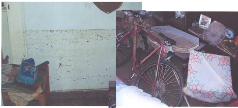
Εικόνα 2-5. Μη δομική πλημμυρική ζημιά σε ισόγειο αστικής περιοχής της Αττικής [Πηγή: λήψη φωτογραφίας Ιούλιος 2002, από Υπηρεσία Αποκατάστασης Σεισμοπλήκτων, ΥΠΕΧΩΔΕ]
