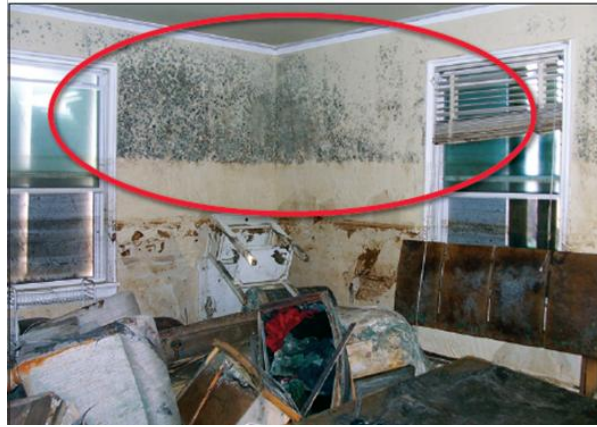
Εικόνα 2-7. Δείγμα μη δομικής, πλημμυρικής ζημιάς σε κατοικία στην Νέα Ορλεάνη, με εκτεταμένη ανάπτυξη μούχλας [Πηγή: FEMA – Mitigation Assessment Team Report 2006]
