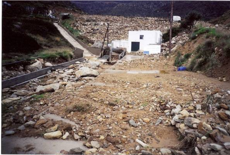
Εικόνα 13-3. Κατάντη όψη φράγματος μετά το ατυχές συμβάν και υλικά που διαβρώθηκαν και παρασύρθηκαν
