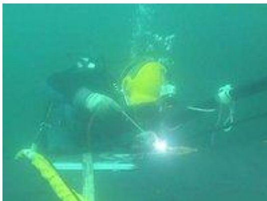
Φωτογραφία 3.8: Υποβρύχια κοπή με επενδυμένα ηλεκτρόδια
