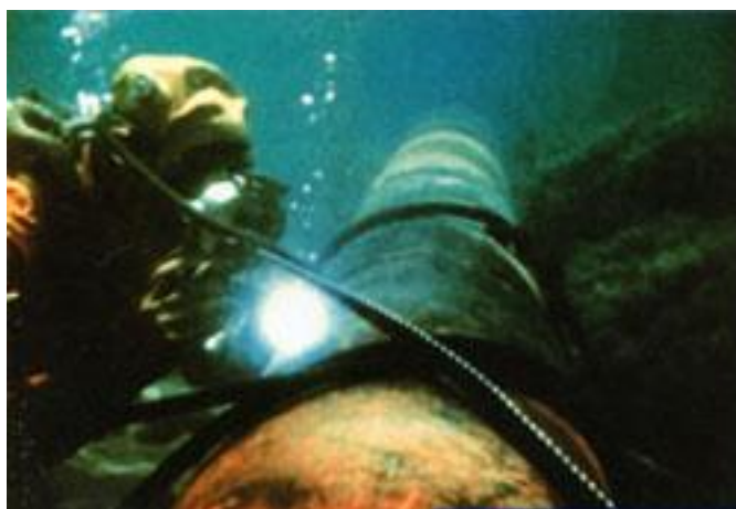
Φωτογραφία 3.17: Υποβρύχια κοπή με χρήση σωληνοειδών ηλεκτρόδιων
