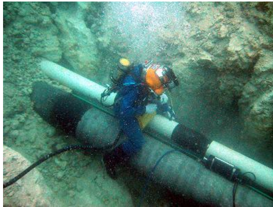
Φωτογραφία 1.5: Υποβρύχιες εργασίες σε υποθαλάσσιες σωληνώσεις
