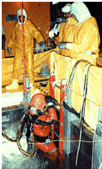
Φωτογραφία 1.6: Υποβρύχιες εργασίες σε πυρηνικές εγκαταστάσεις
