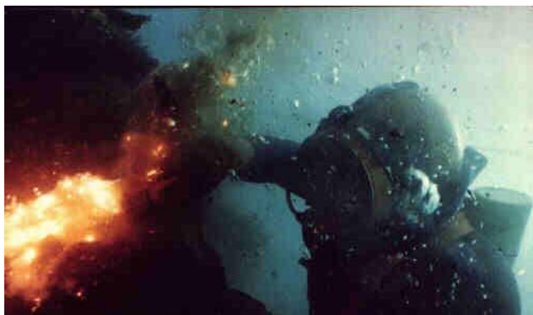
Φωτογραφία 3.4: Υποβρύχια κοπή με εξωθερμικά ηλεκτρόδια
