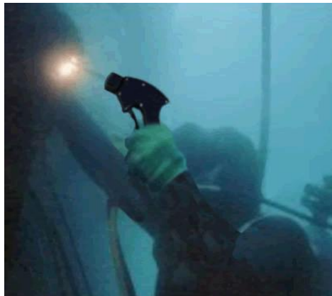
Φωτογραφία 3.9: Υποβρύχια κοπή με οξυγόνο
