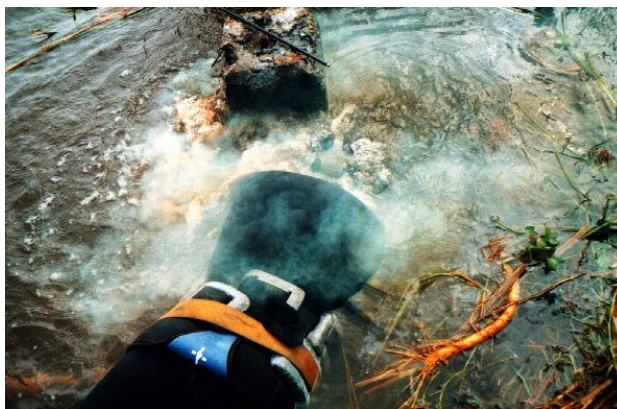
Φωτογραφία 3.11: Υποβρύχια κοπή τσιμέντου με θερμική λόγξη
