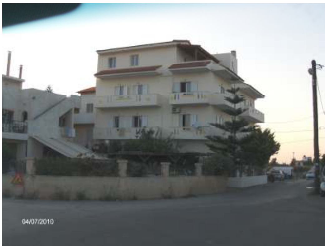
Τετραόροφη οικοδομή α' κατοικίας
