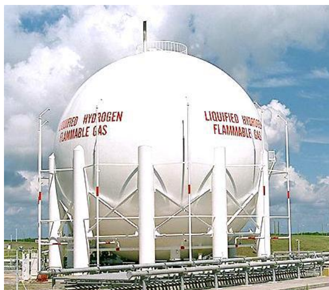
Σχήμα 4.6. Σφαιρική κρυογενική δεξαμενή αποθήκευσης υγρού υδρογόνου [19]
