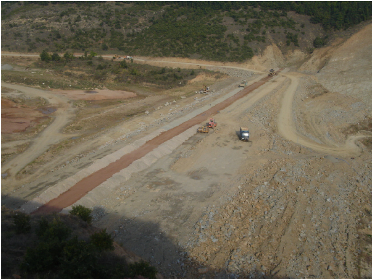
Εικόνα 5.2. Διάστρωση αργιλικού πυρήνα προφράγματος
