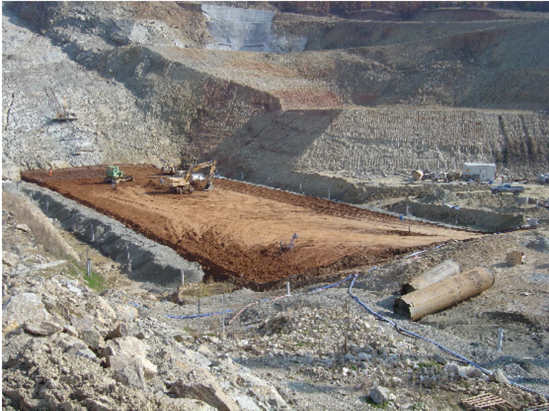
Εικόνα 5.18 Διάστρωση Ζώνης 1 φράγματος
