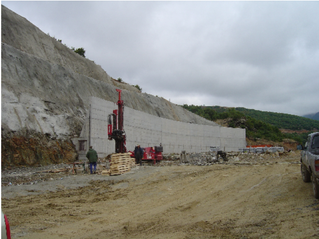
Εικόνα 5.32. Ανόρυξη ερευνητικών γεωτρήσεων στη θεμελίωση του υπερχειλιστή
