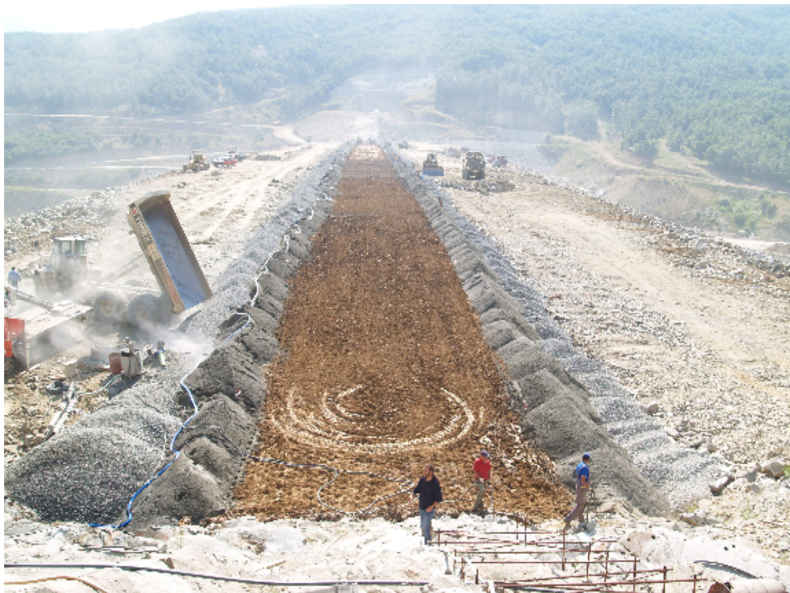
Εικόνα 5.14. Διάστρωση ζωνών αναχώματος
