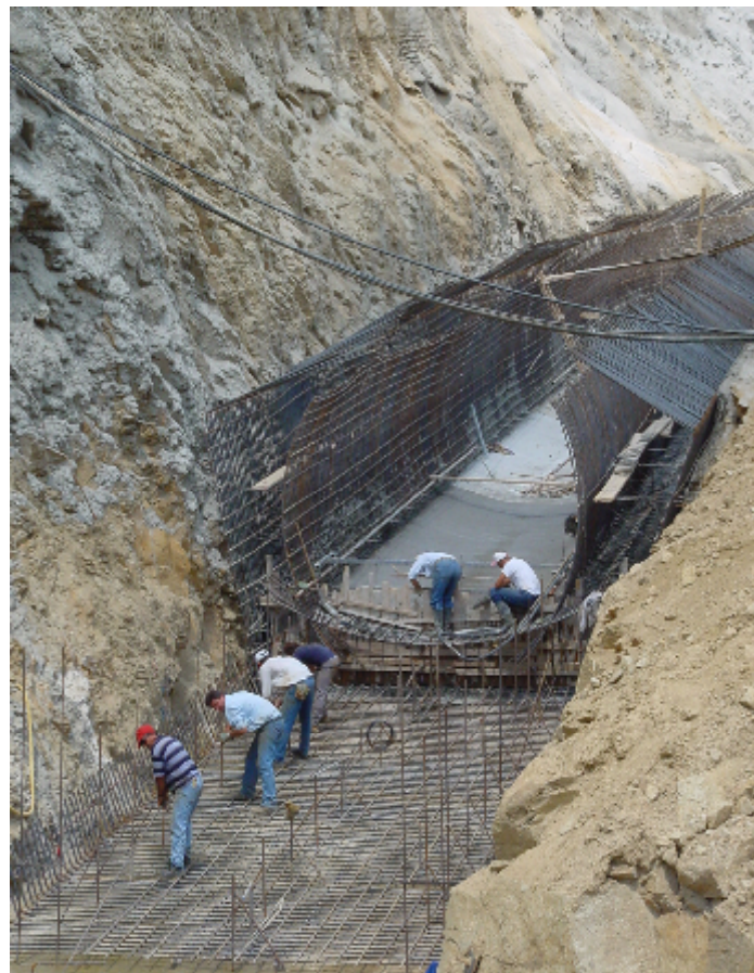
Εικόνα 5.12. Κατασκευή τμήματος αγωγού εκτροπής
