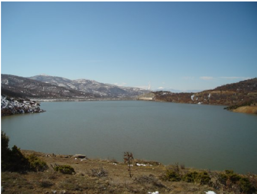
Εικόνα 7.3. Η περιοχή του έργου μετά την πλήρωση του ταμιευτήρα και την ολοκλήρωση των εργασιών αποκατάστασης
