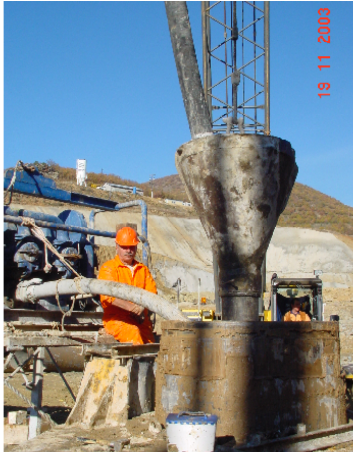
Εικόνα 5.9. Σκυροδέτηση
