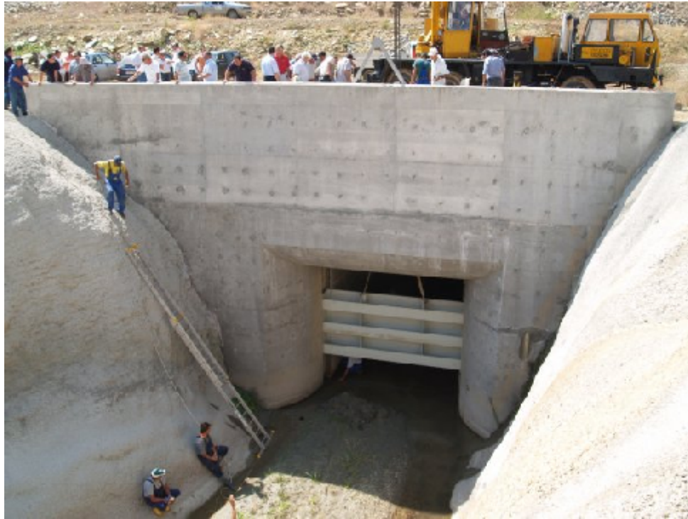
Εικόνα 5.11. Είσοδος αγωγού εκτροπής
