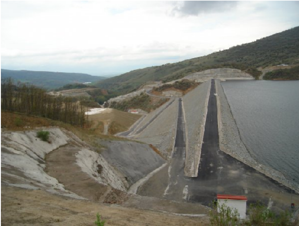
Εικόνα 7.2. Έργα αποκατάστασης και οδοποιΐας
