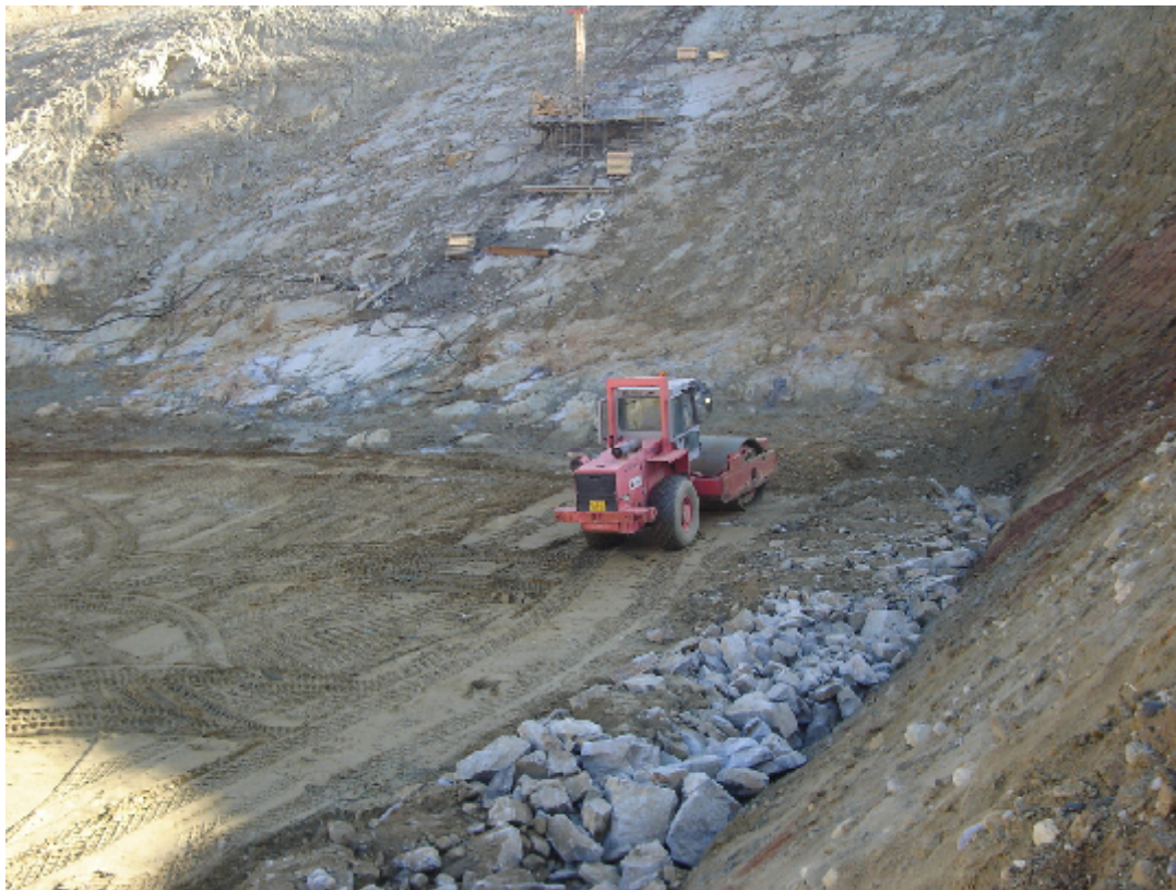
Εικόνα 5.27. Διαδικασία συμπύκνωσης Ζώνης 1 σε επαφή με τη θεμελίωση
