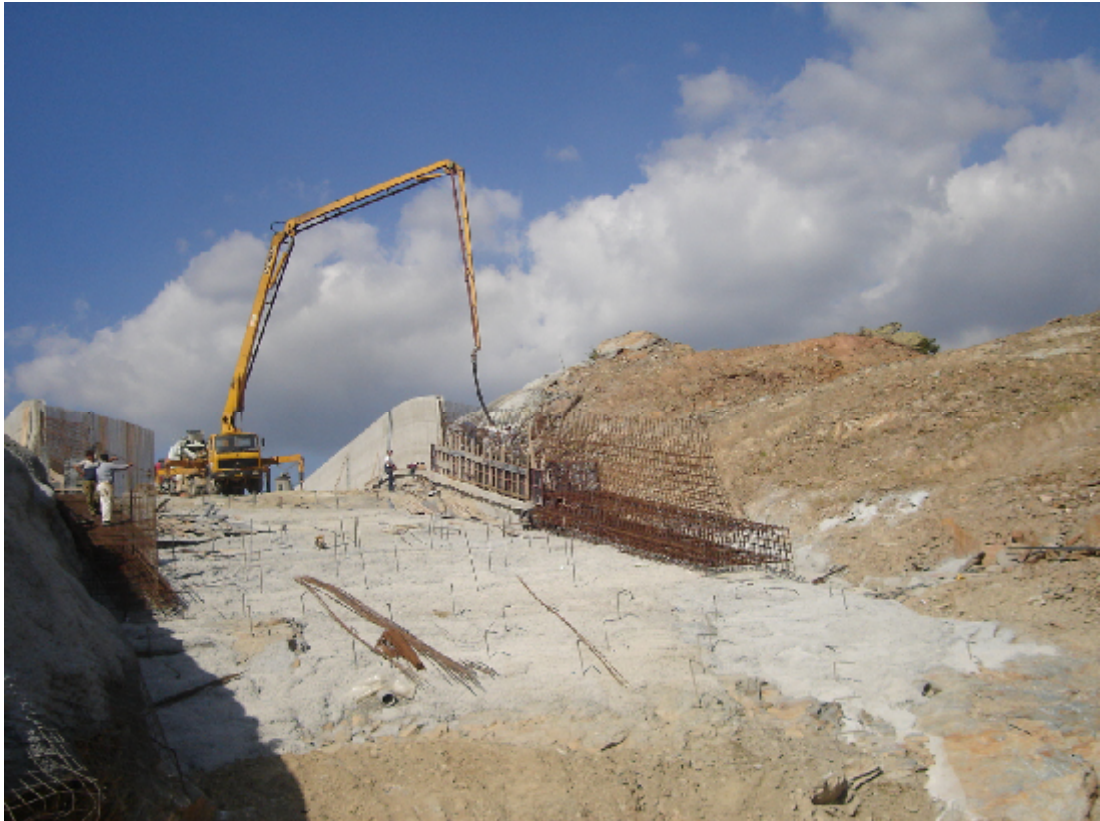
Εικόνα 5.34. Σκυροδέτηση τμήματος υπερχειλιστή
