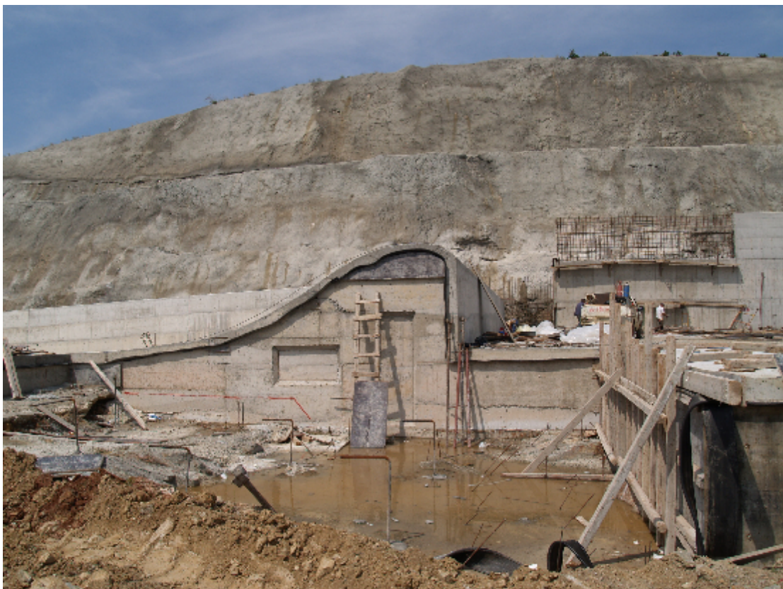
Εικόνα 5.35. Η είσοδος υπερχείλισης κατά την κατασκευή
