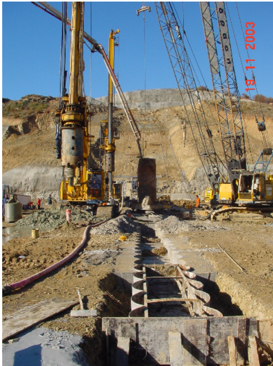
Εικόνα 5.5. Φάση κατασκευής πασσαλοστοιχίας
