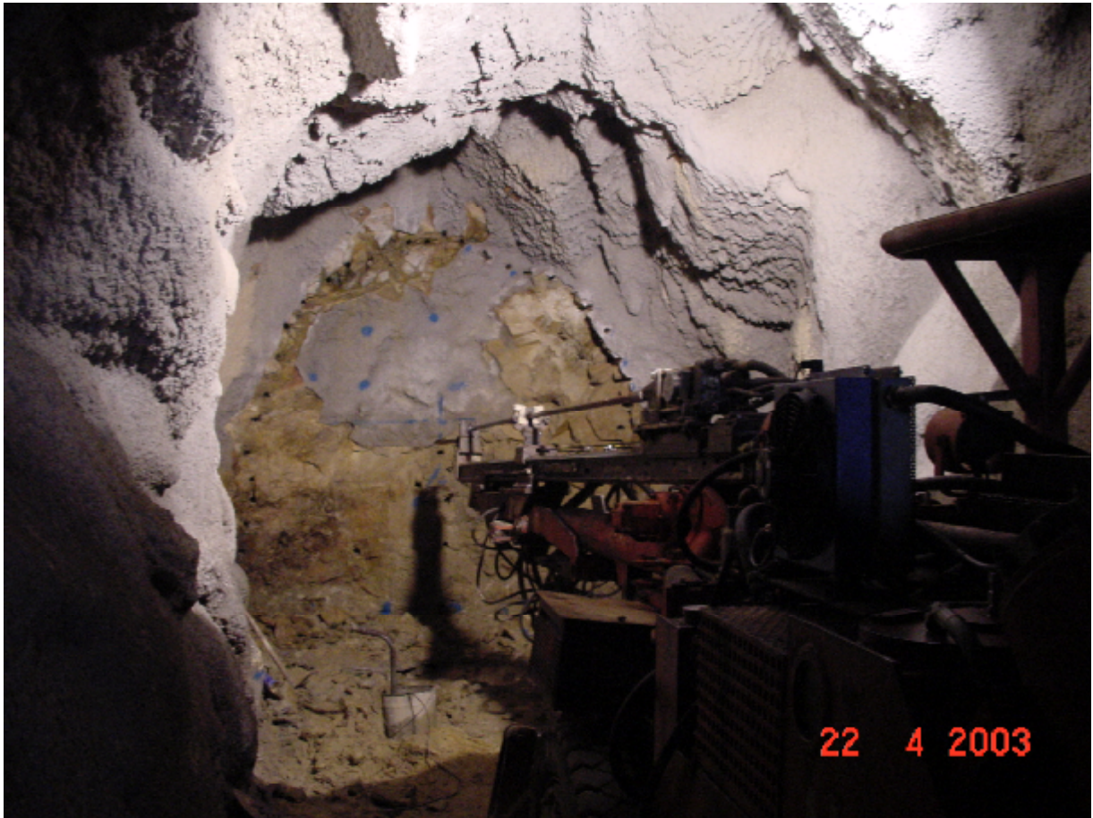
Εικόνα 5.13. Διάνοιξη διατρημάτων
