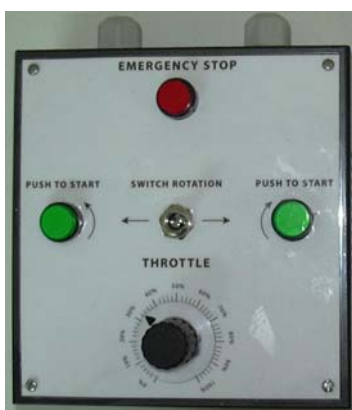
Σχήμα 2.41: Χειριστήριο ελέγχου AC 3Φ κινητήρα πρώτης πτερωτής.
