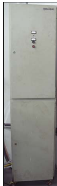
Σχήμα 2.45: Καμπίνα ρύθμισης στροφών DC κινητήρα δεύτερης πτερωτής.
