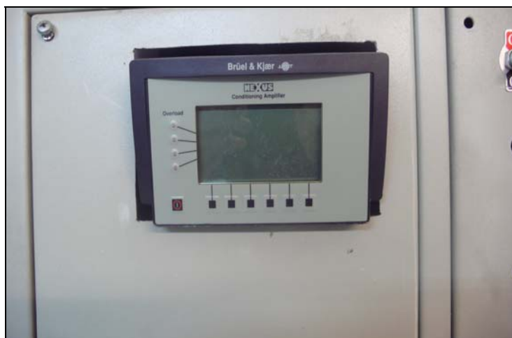
Σχήμα 3.37: Ενισχυτής σήματος εξόδου επιταχυνσιμέτρων της διάταξης.
