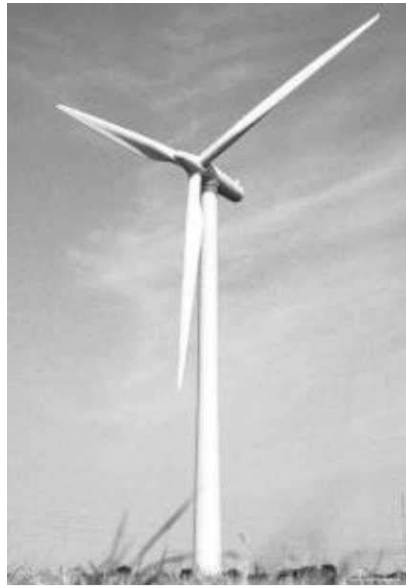
Σχήμα 3.2 Ανεμογεννήτρια οριζόντιου άξονα με τρία πτερύγια.
