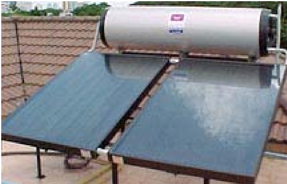
Σχήμα 2.4: Ηλιακό θερμοσιφωνικό σύστημα για θέρμανση νερού
