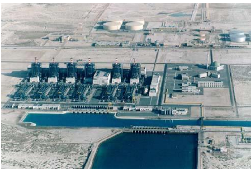
Εικόνα 177: Σύστημα Αφαλάτωσης Shuaiba III στην Σαουδική Αραβία.[74]
