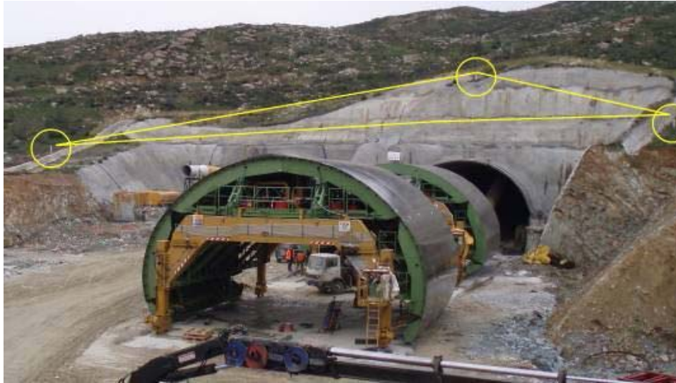
Σχήμα 6.3: Τα Γεωδαιτικά βάθρα στην περίμετρο της εισόδου της σήραγγας.
