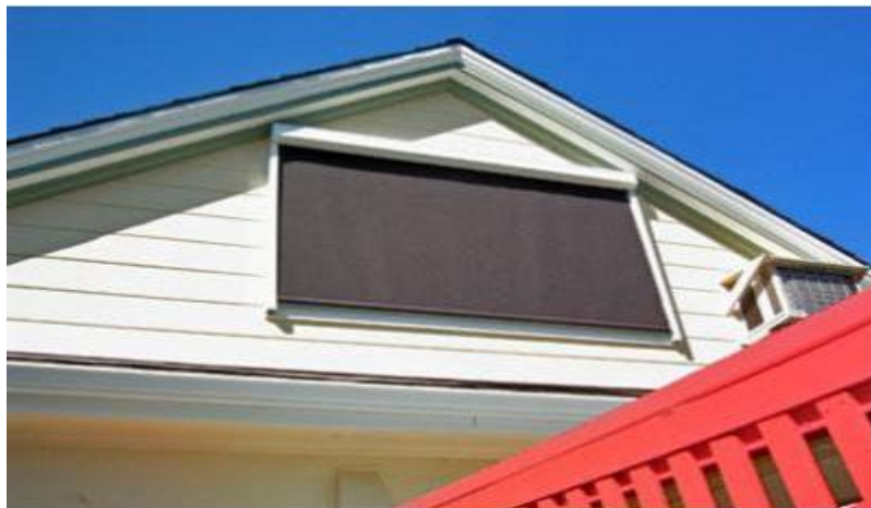
Σχήμα 8-Παράδειγμα εξωτερικής σκίασης
