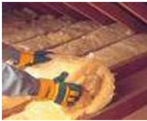
Σχήμα 14-Μόνωση σοφίτας(εύκολη τοποθέτηση)
