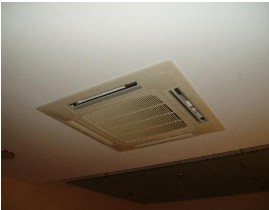
Σχήμα 25-Φωτογραφία Μονάδας Παροχής Θέρμανσης-Ψύξης(οροφή)
