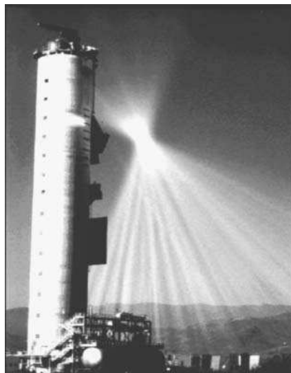
Σχήμα 3.5: Πλάγια όψη του τσιμεντένιου πύργου ύψους 80 m της μονάδας CESA-1 στην εγκατάσταση Plataforma Solar de Almeri´a στην Ισπανία.
