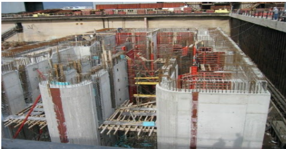
Σχήμα 3.6-2 Κατά τη διάρκεια της κατασκευής
