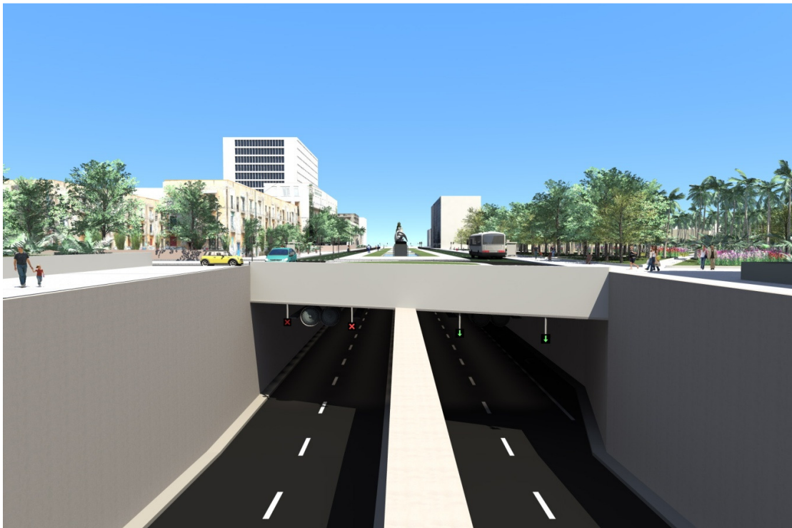
Εικόνα 5-1: Είσοδος - Έξοδος Υπόγειας Διάβασης (ΠΗΓΗ: Προσωπικό αρχείο)
