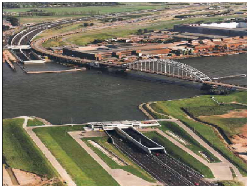
Εικόνα 3-36: Σήραγγα Noord, Άμστερνταμ
