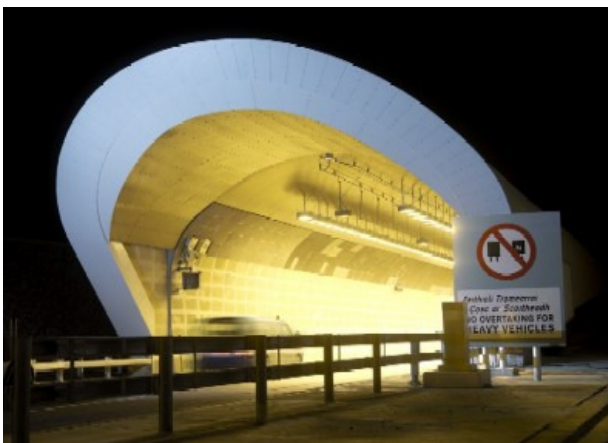
Εικόνα 3-34: Είσοδος της σήραγγας Duplin Port Tunnel (ΠΗΓΗ: www.nra.ie/ TendersRecruitment )
