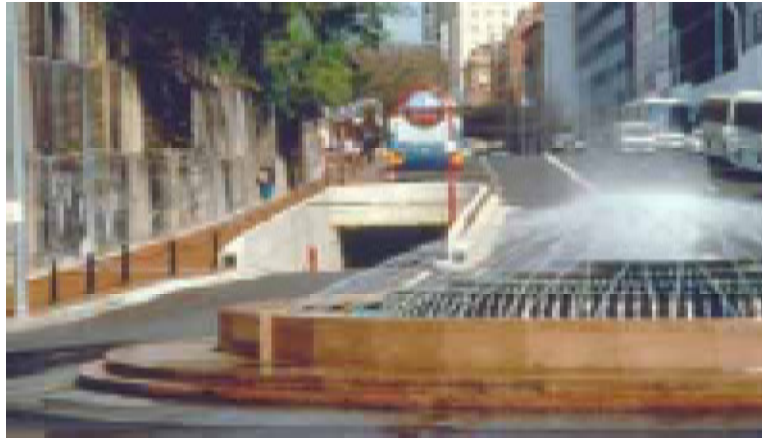
Εικόνα 3-8: Είσοδος του υπογείου parking της όπερας του Σύδνεϋ από παράπλευρο δρόμο (ΠΗΓΗ: www.sydneyoperahouse.com )
