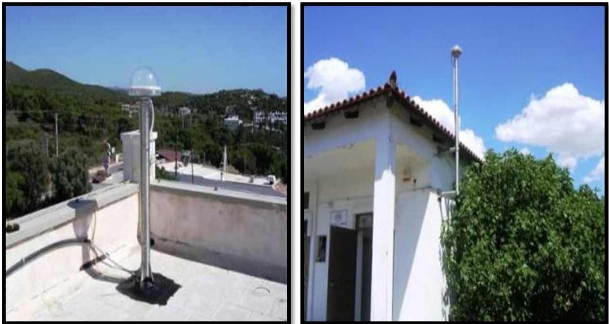
Εικόνα 3.2 Κεραία Σταθμού Αναφοράς του HEPOS τοποθετημένη σε βάθρο σε οροφή και σε τοίχο [Πηγή : http://www.hepos.gr/ ]
