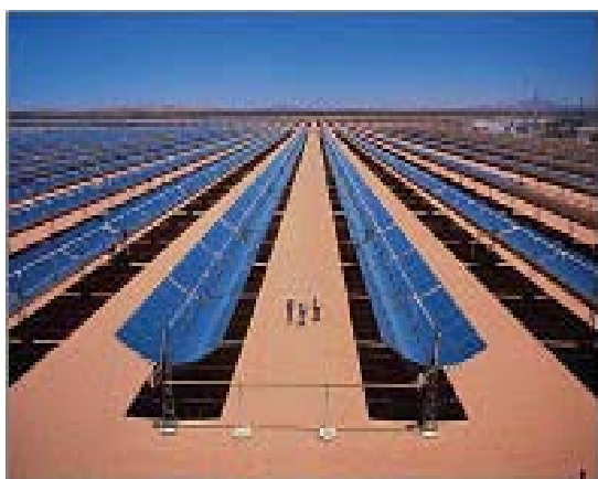
Εικόνα 3.3: Συλλέκτες γραμμικής εστίασης (αριστερά) και συλλέκτης σημειακής εστίασης (δεξιά) [13]
