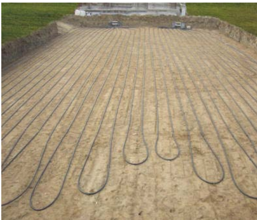
Εικόνα 4.9: Οριζόντια διάταξη γεωεναλλακτών [35]
