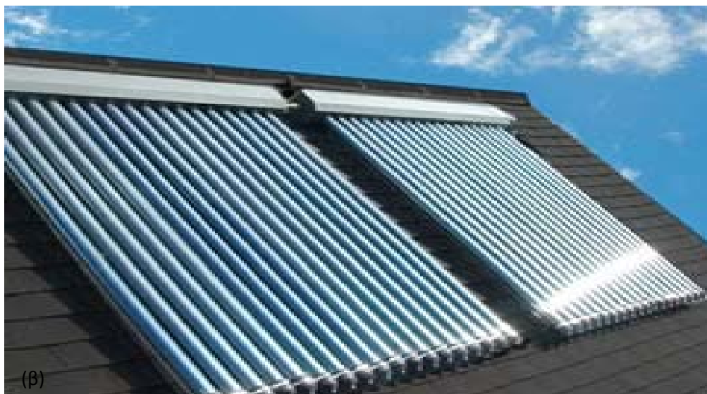
Εικόνα 3.2: (α) Κύρια μέρη συλλέκτη κενού [1] (β) Συλλέκτες κενού [13]
