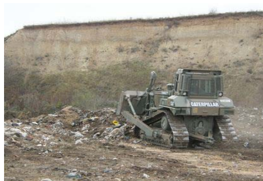
Εικόνα 1.3: Όχημα του Μηχανικού σε εργασίες διαμόρφωσης αγροτικού δρόμου [40]
