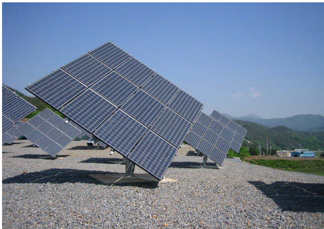
Εικόνα 2.6: Φ/Β με περιστρεφόμενο σύστημα στήριξης διπλού άξονα [24]
