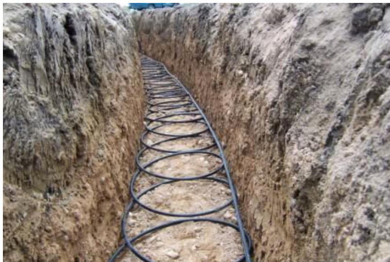
ΕΙΚΟΝΑ 58: Εκσκαφή μορφής ορύγματος και σπειροειδείς σωληνώσεις
