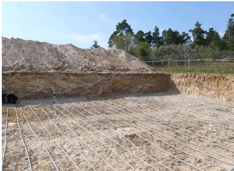
ΕΙΚΟΝΑ 57: Εκσκαφή μορφής ολικής απομάκρυνσης εδάφους και πολλαπλές σωληνώσεις
