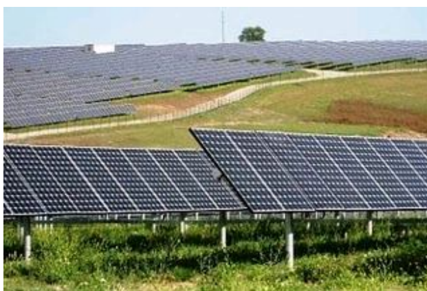
ΕΙΚΟΝΑ 33: Σύστημα σταθερών συλλεκτών
