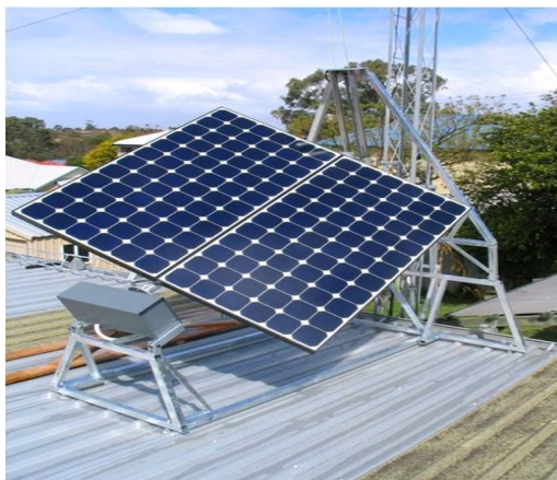
ΕΙΚΟΝΑ 36: Σύστημα παρακολούθησης της τροχιάς σε 2 άξονες ( http://www.solar-tracking.com/images/dual_axis_icon.png )
