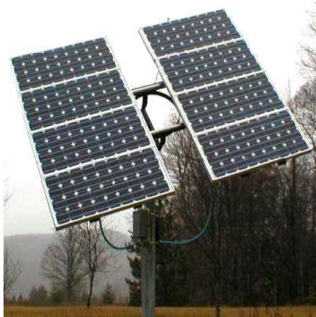
ΕΙΚΟΝΑ 35: Σύστημα παρακολούθησης της τροχιάς στον οριζόντιο άξονα (Περιστροφή περί τον άξονα Ψ) ( http://www.solar-tracking.com/images/single_axis_icon2.png )
