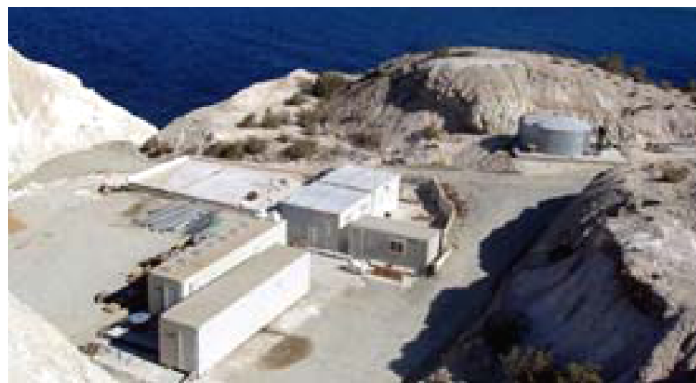
Σχήμα 5.7 Μονάδα αφαλάτωσης στη Μήλο
