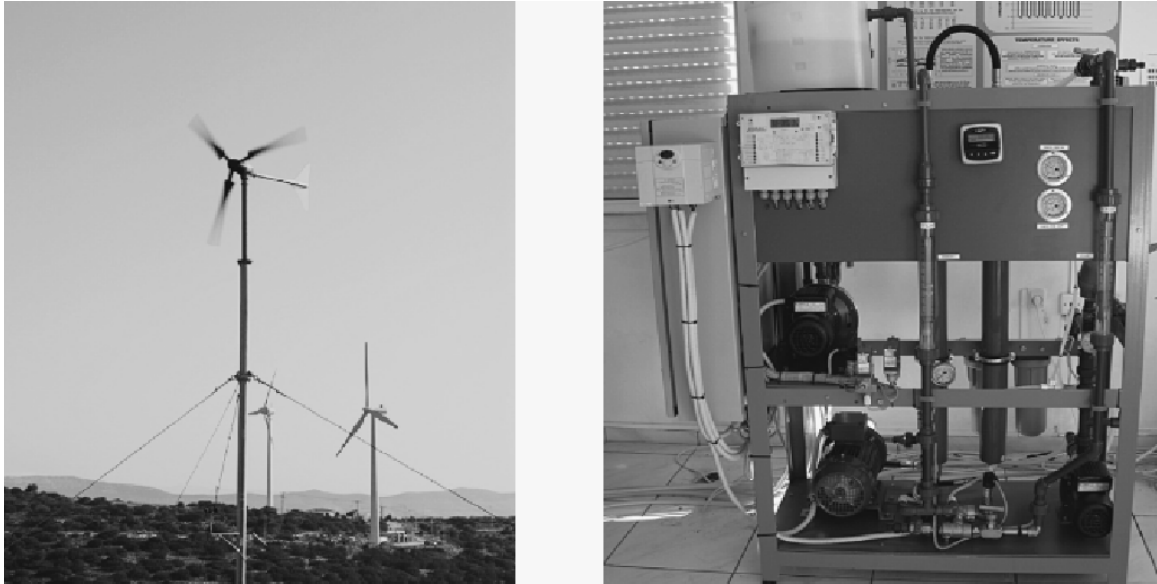
Σχήμα 5.5 Μονάδα αφαλάτωσης (δεξιά) και εγκατεστημένο αιολικό πάρκο 900W (αριστερά) από το ΚΑΠΕ
