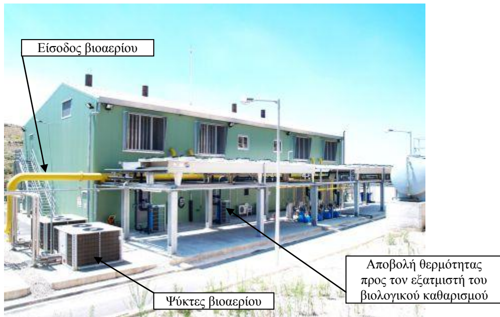
Εικόνα: Κτίριο που στεγάζει τις μηχανές του τμήματος 2
