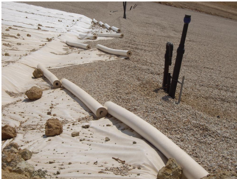
Εικόνα: Στρώσεις χαλικιών και μεμβράνης πάνω από τα απορρίμματα
