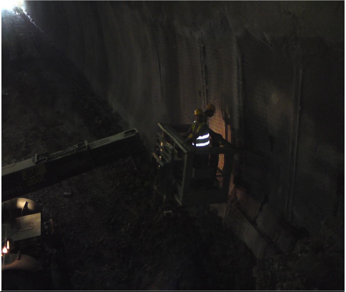
Φωτογραφία 5.3: Στήριξη δικτυωτών πλαισίων
