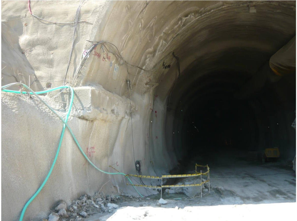
Φωτογραφία 5.6: Στις εισόδους των σηράγγων εφαρμόζεται η κατηγορία υποστήριξης M_V
