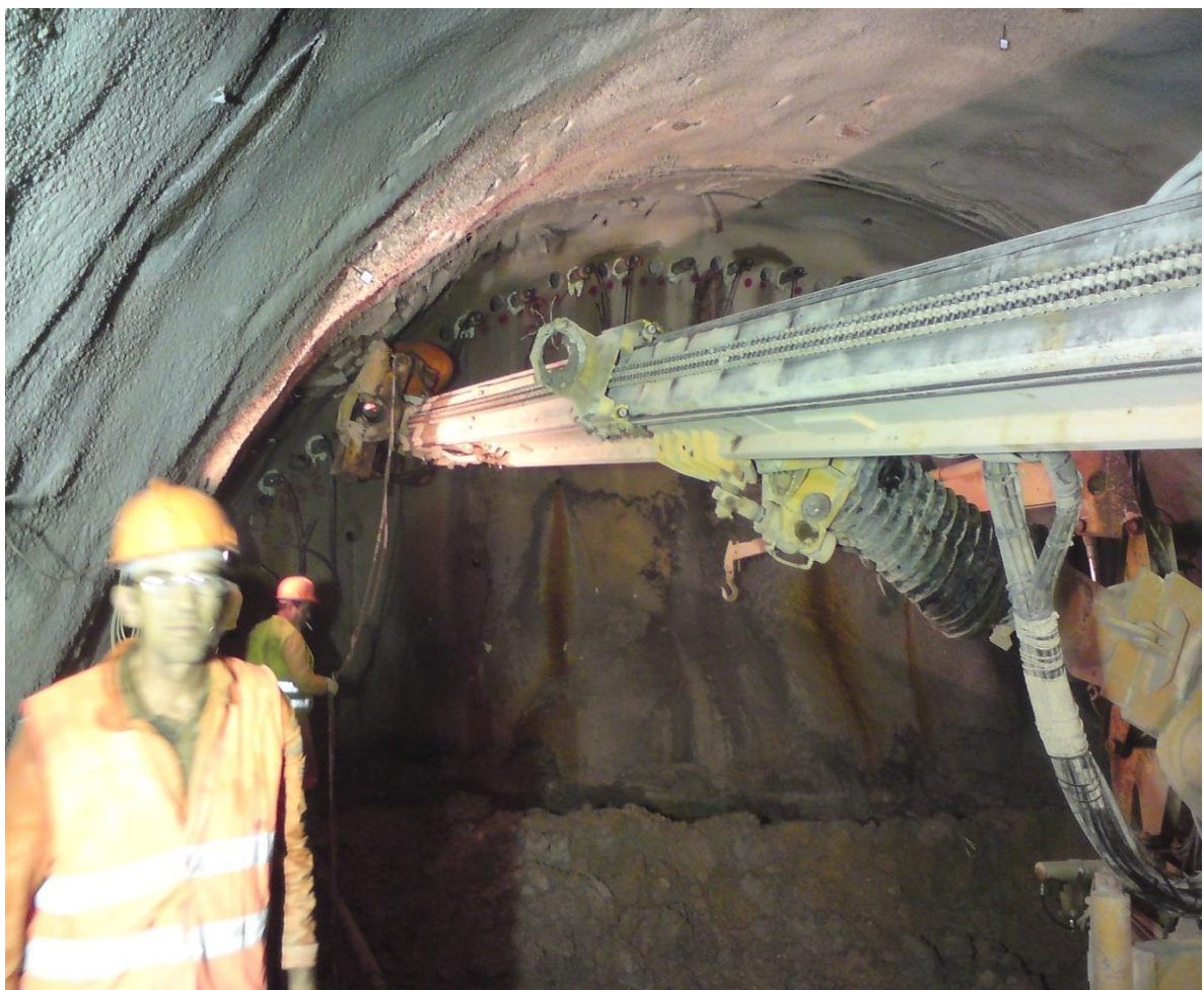
Φωτογραφία 5.5: Τοποθέτηση χαλύβδινων ράβδων προενίσχυσης μετώπου στη ημιδιατομή της σήραγγας
