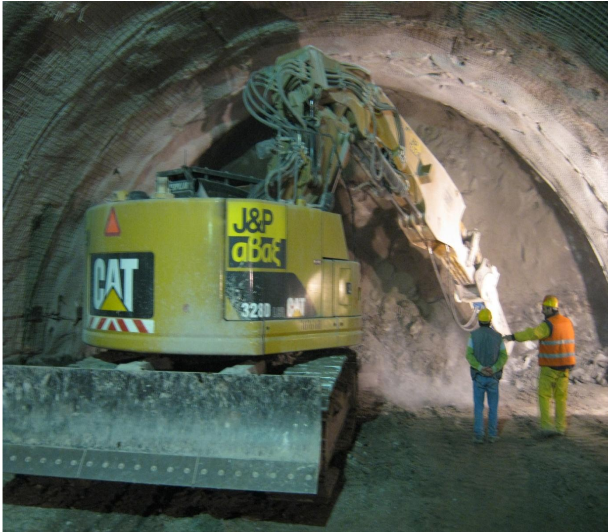
Φωτογραφία 5.1: Εκσκαφή α φάσης (ημιδιατομή)
