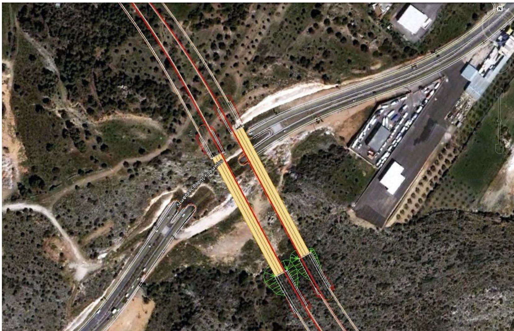
Εικόνα Π- 6: Διασταύρωση Αυτοκινητοδρόμου με τη Λεωφόρο Βάρης – Κορωπίου (Γέφυρα)
