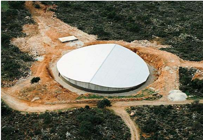
Εικόνα 1.4: Προεντεταμένη δεξαμενή νερού 4.000 μ 3
