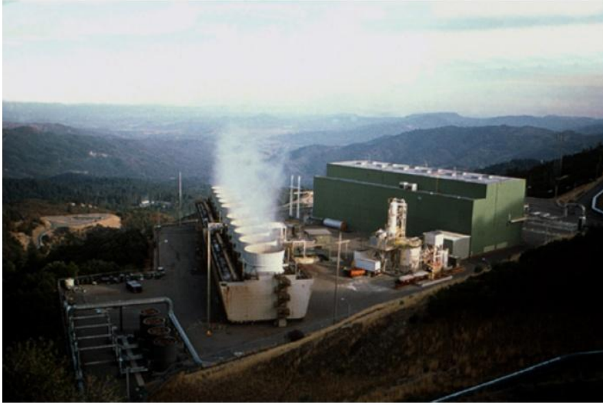
Εικόνα 1.8: Μονάδα παραγωγής ηλεκτρικής ενέργειας στην περιοχή Geysers, Καλιφόρνια (Πηγή: www.geothermal.marin.org )
