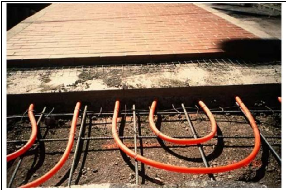
Εικόνα 1.9: Σωλήνες γεωθερμικού ρευστού μπορούν να τοποθετηθούν κάτω από δρόμους-πεζοδρόμια για αντιπαγετική προστασία (Πηγή: Geothermal Education Office, www.geothermal.marin.org )
