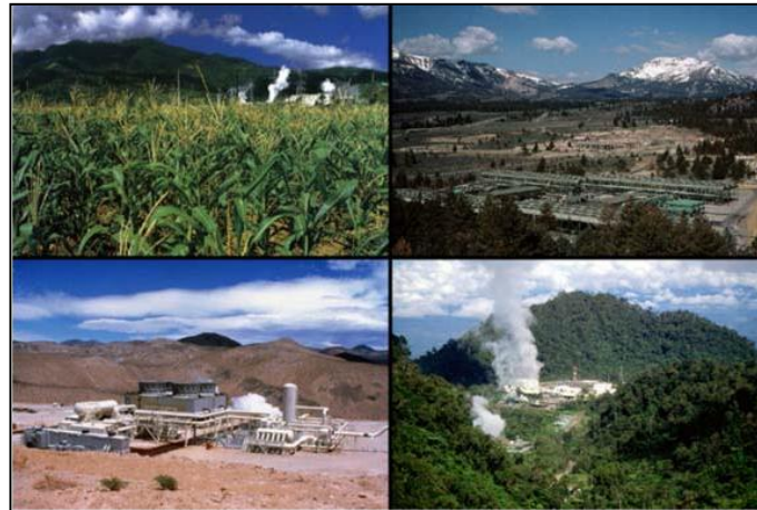
Εικόνα 1.26: Διάφοροι γεωθερμικοί σταθμοί ανά τον κόσμο (Πηγή: www.geothermal.marin.org )
