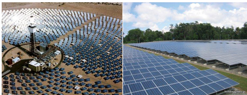
Εικόνα 1.1α-Ηλιοθερμικός και 1.1β-Φωτοβολταϊκό Πάρκο
