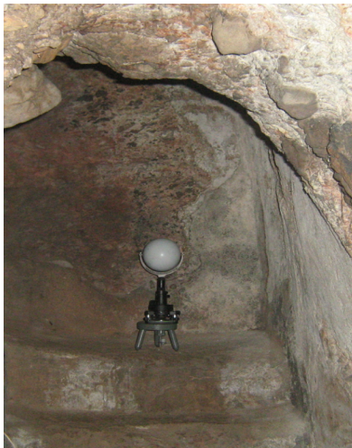
Εικόνα 5-3 Ειδικός σφαιρικός στόχος πάνω σε βάση εξαναγκασμένης κέντρωσης (στάση Κ2).
