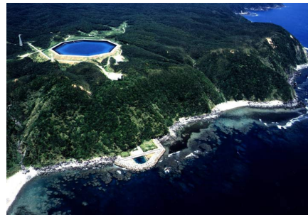
Σχήμα 2.8. Μονάδα αντλησιοταμίευσης στην Okinawa της Ιαπωνίας. Η θάλασσα παίζει τον ρόλο της κάτω δεξαμενής [21].
