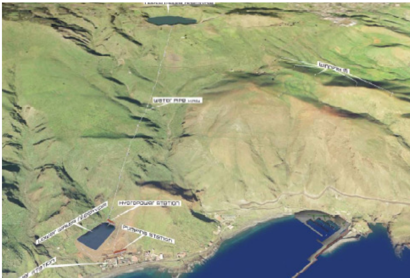
Σχήμα 2.12. Η μονάδα αντλησιοταμίευσης στο νησί El Hierro- Κανάρια νησιά [37].
