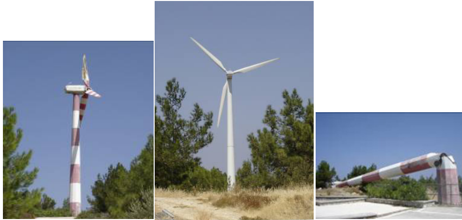
Σχήμα 3.8. Α/Γ στην περιοχή Κράτηγου (2 κατεστραμμένες, 1 σε λειτουργία).
