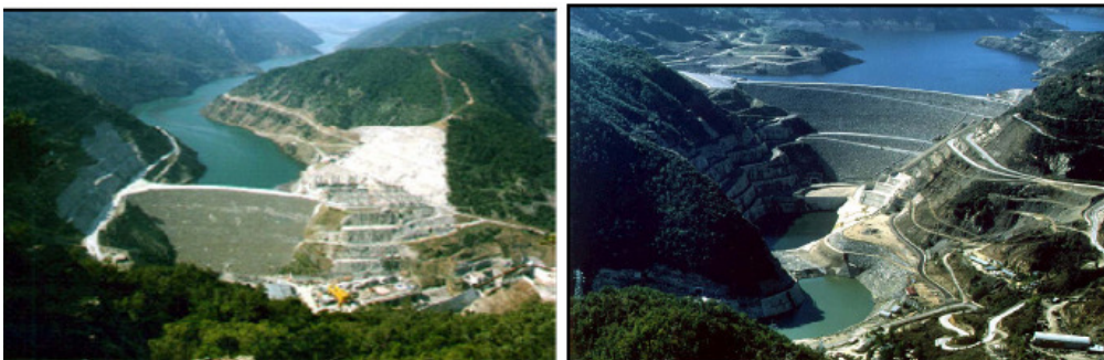
Σχήμα 2.11. Αριστερά: Η μονάδα αντλιοσταμείωσης στον Σφηκιά. Δεξιά: Η μονάδα αντλιοσταμείωσης στον Θησαυρό [24].
