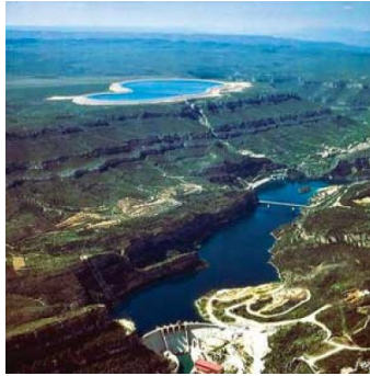
Σχήμα 2.7. Μονάδα αντλησιοταμίευσης (La Muela) στην Ισπανία με συνολική εγκατεστημένη ισχύ 635 MW. Αυτή τη στιγμή η μονάδα επεκτείνεται με την προσθήκη 852 MW (La Muela 2) και αναμένεται να τεθεί σε λειτουργία το 2012 [20].
