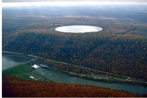
Σχήμα 2.10. Μονάδα αντλιοσταμείωσης στην Πενσυλβανία με συνολική εγκατεστημένη ισχύ 435 MW [21].
