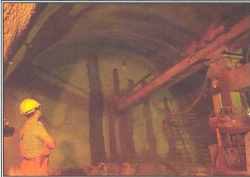
Εικόνα 6: Διάτρηση οπών στο μέτωπο για την τοποθέτηση αγκυρίων ινών υάλου
