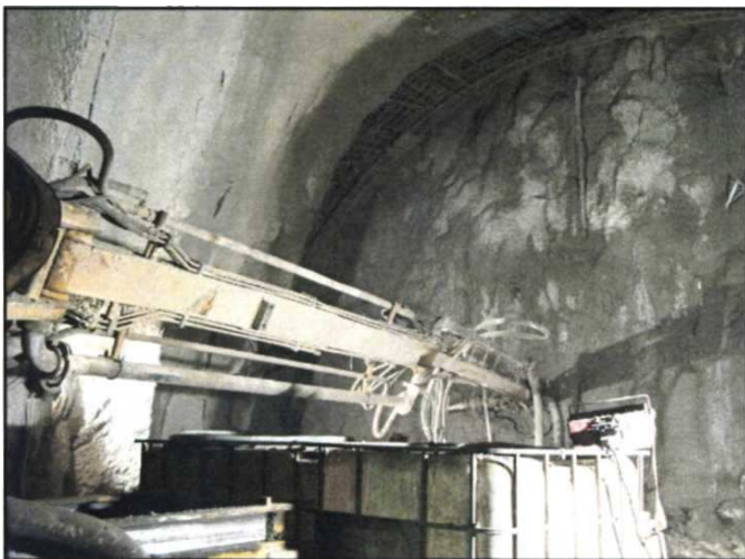
Εικόνα 8: Εφαρμογή 1 ης στρώσης εκτοξευόμενου σκυροδέματος στο μέτωπο
