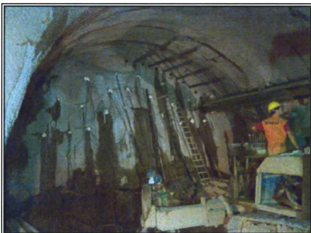
Εικόνα 5: Τοποθέτηση δοκών προτορείας
