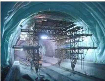
Εικόνα 12: Τοποθέτηση Γεωφάσματος (PVC)
