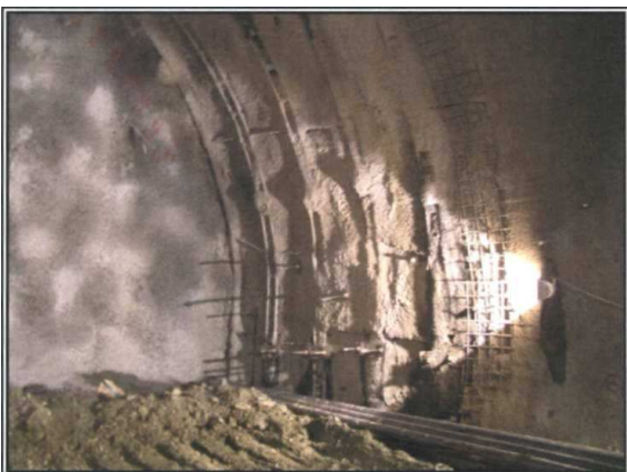
Εικόνα 10 : Αγκυρώσεις, πλαίσια, πλέγμα έσω παρειάς
