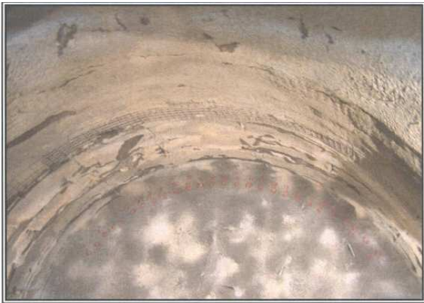
Εικόνα 3: Αρίθμηση των θέσεων όπου θα διατηρηθούν οπές για την τοποθέτηση των δοκών προτορείας
