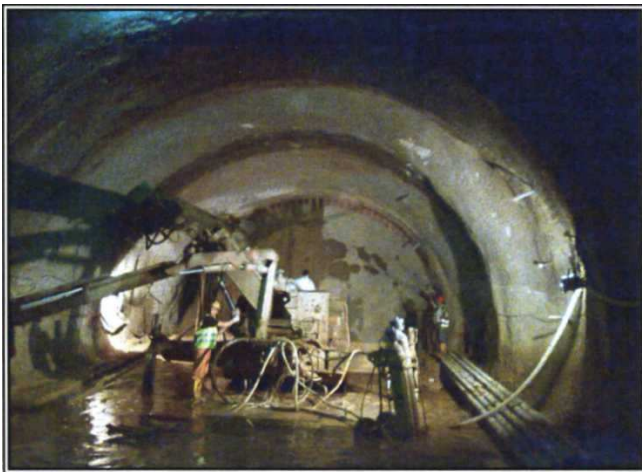
Εικόνα 4: Διάρθρωση οπών στο μέτωπο για τη τοποθέτηση δοκών προτορείας
