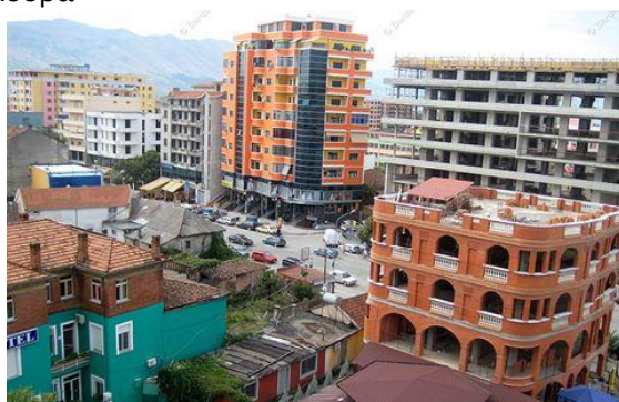
Νέα κτίρια σε κεντρικό σημείο της πόλης
