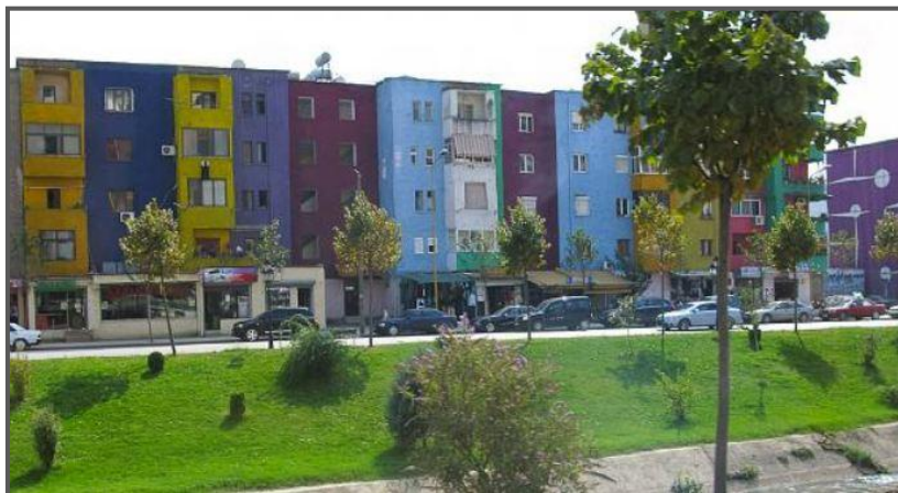
Πολυκατοικίες και κεντρικό δρόμο στα Τίρανα που συντηρήθηκαν από τον Δήμο
