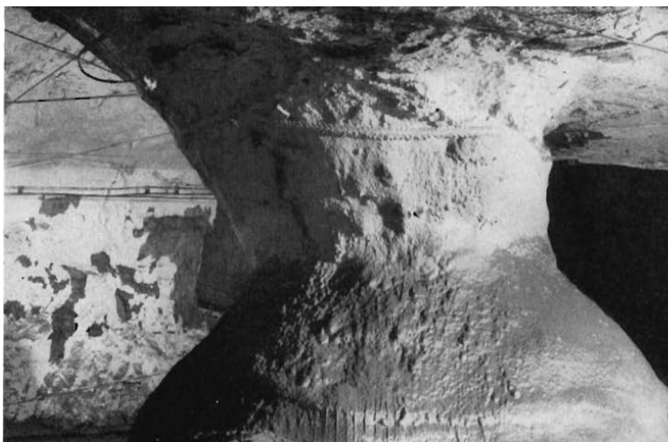
Εικόνα 3.4. Στύλος με μορφή κλεψύδρας για την υποστήριξη του οποίου χρησιμοποιήθηκε εκτοξευόμενο σκυρόδεμα σε συνδυασμό με πλέγμα.
