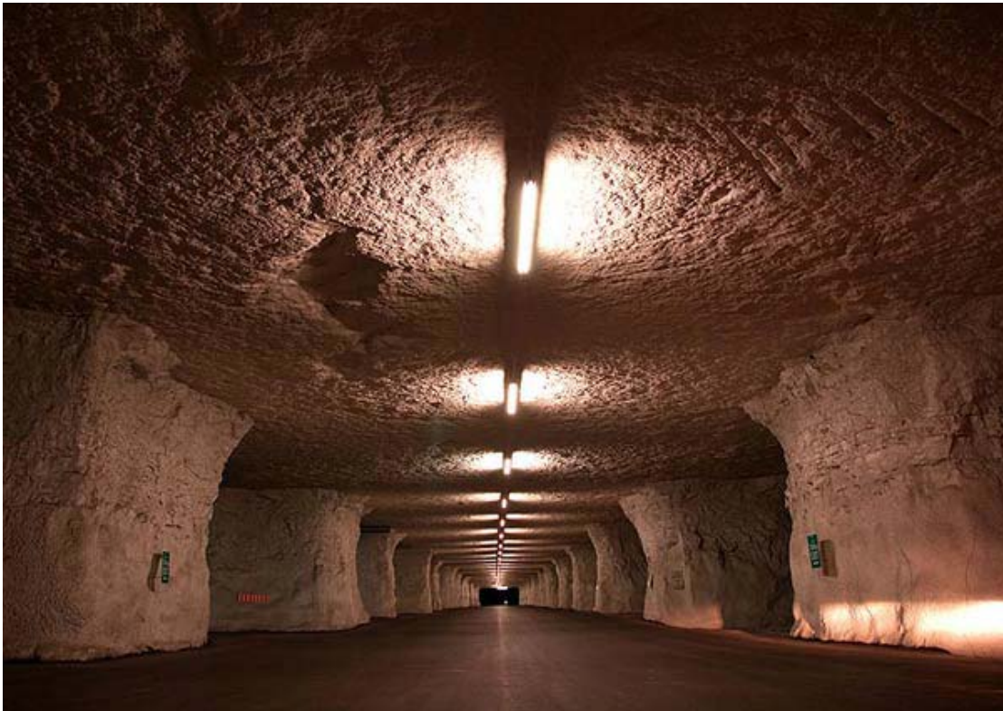
Εικόνα 1.2. Αποψη υπογείων χώρων του Subtropolis. Διακρίνεται χαρακτηριστικά η διάταξη των στύλων του πετρώματος.
