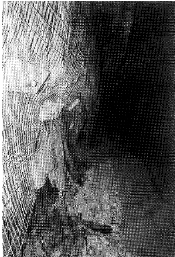
Εικόνα 3.3. Χρήση πλέγματος για την ενίσχυση στύλου.
