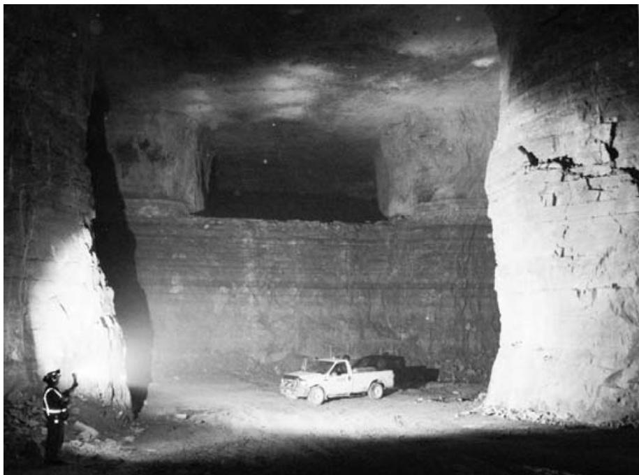
Εικόνα 2.1. Στύλοι που διαμορφώθηκαν με τη χρήση βαθμίδων εκμετάλλευσης. (Esterhuizen et al., 2007)
