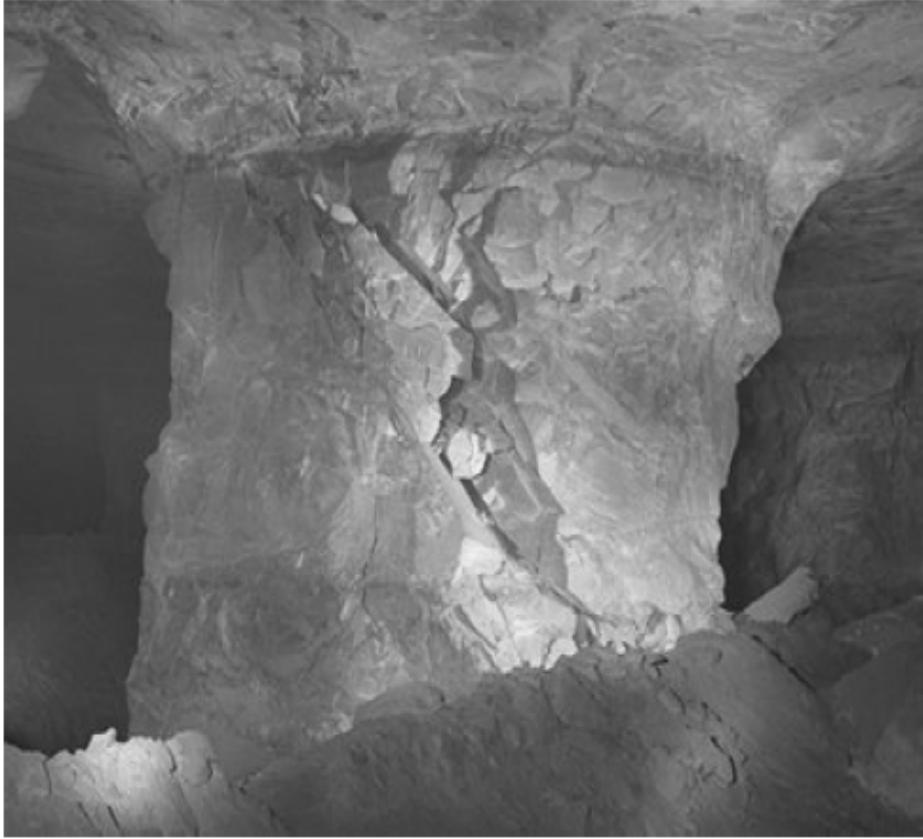
Εικόνα 2.2. Στύλος που διαμορφώθηκε με τη χρήση βαθμίδας και αστόχησε κατά μήκος δύο ασυνεχειών που έχουν κλίση περίπου 60^\circ ( Esterhuizen, 2006).
