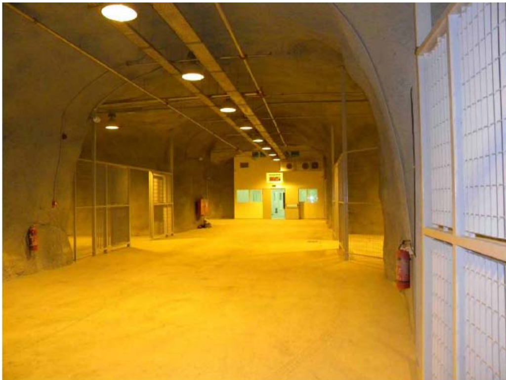
Εικόνα 1.13. Υπόγειες εγκαταστάσεις έτοιμες για την απόθεση των αποβλήτων.
