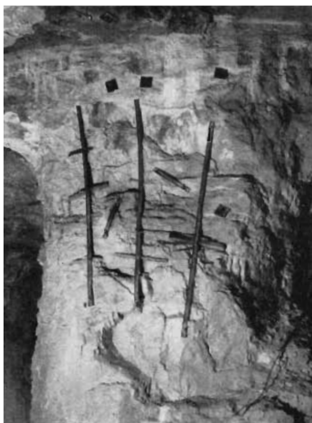
Εικόνα 3.5. Χρήση μεταλλικών λωρίδων σε συνδυασμό με ηλώσεις για την ενίσχυση στύλου που έχει αναπτύξει κατακόρυφες ρωγματώσεις (split pillar).
