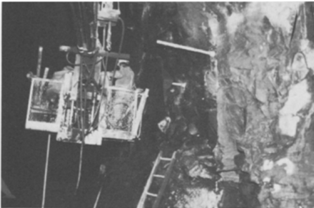
Εικόνα 3.8. Εγκατάσταση αγκυρίων από πλατφόρμα.
