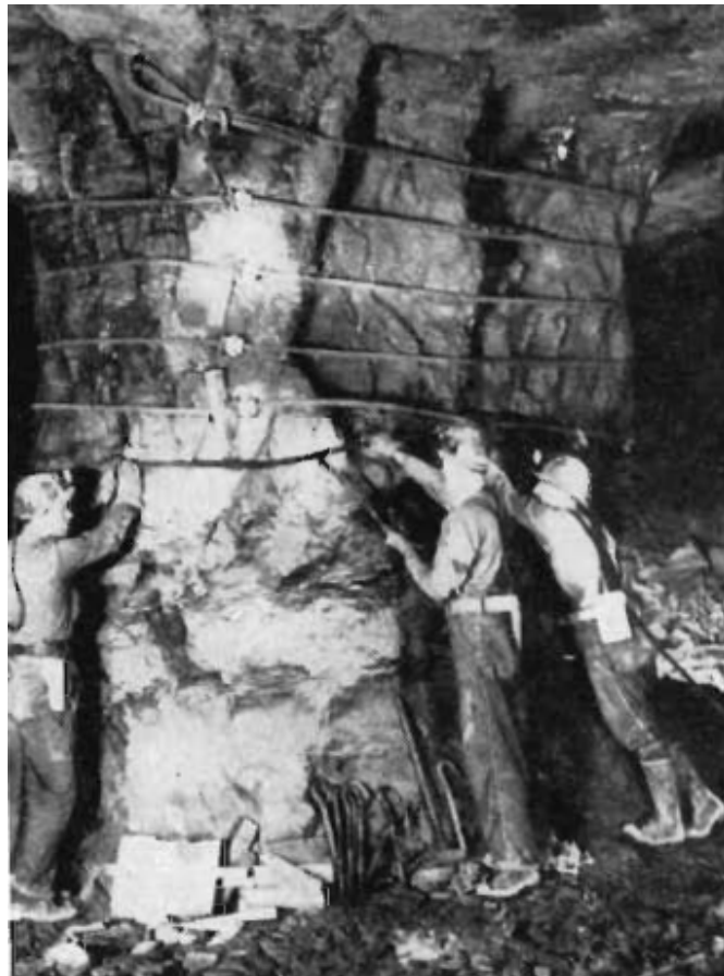
Εικόνα 3.6. Διαδικασία περίδεσης των στύλων.
